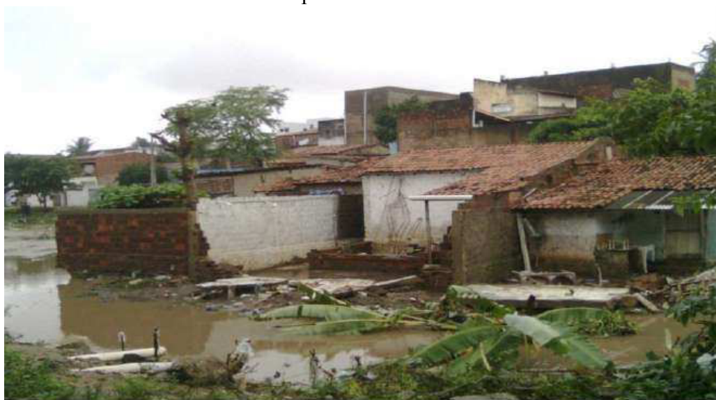
Figura 12: Casas construídas no curso do Canal das Piabas e derrubadas pelas chuvas ocorridas no primeiro semestre de 2011.
