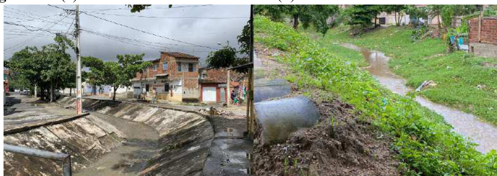
Figura 31: (a) Riacho das Piabas canalizado (b) Riacho das Piabas não canalizado.
