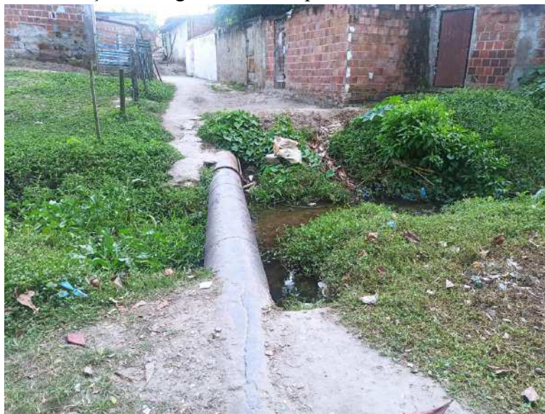
Figura 68: Tubulação de esgoto utilizada para travessia do Riacho das Piabas.
