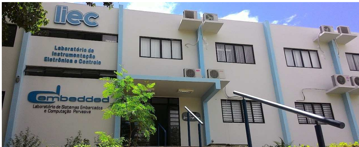
Figura 1 – Fachada do LIEC
