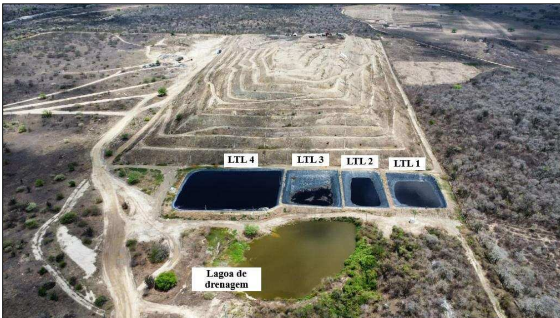
Figura 18 - LTL's e Lagoa de drenagem.
