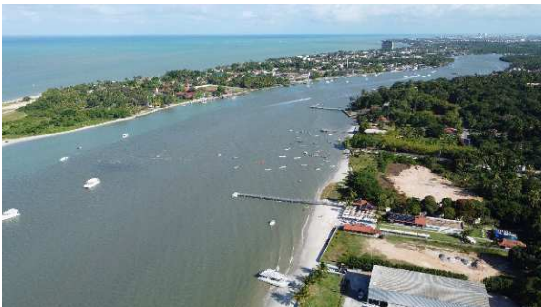
Figura 34 – Zona Estuarina Inferior do ERT, onde se apresentam diversas residências e marinas.
