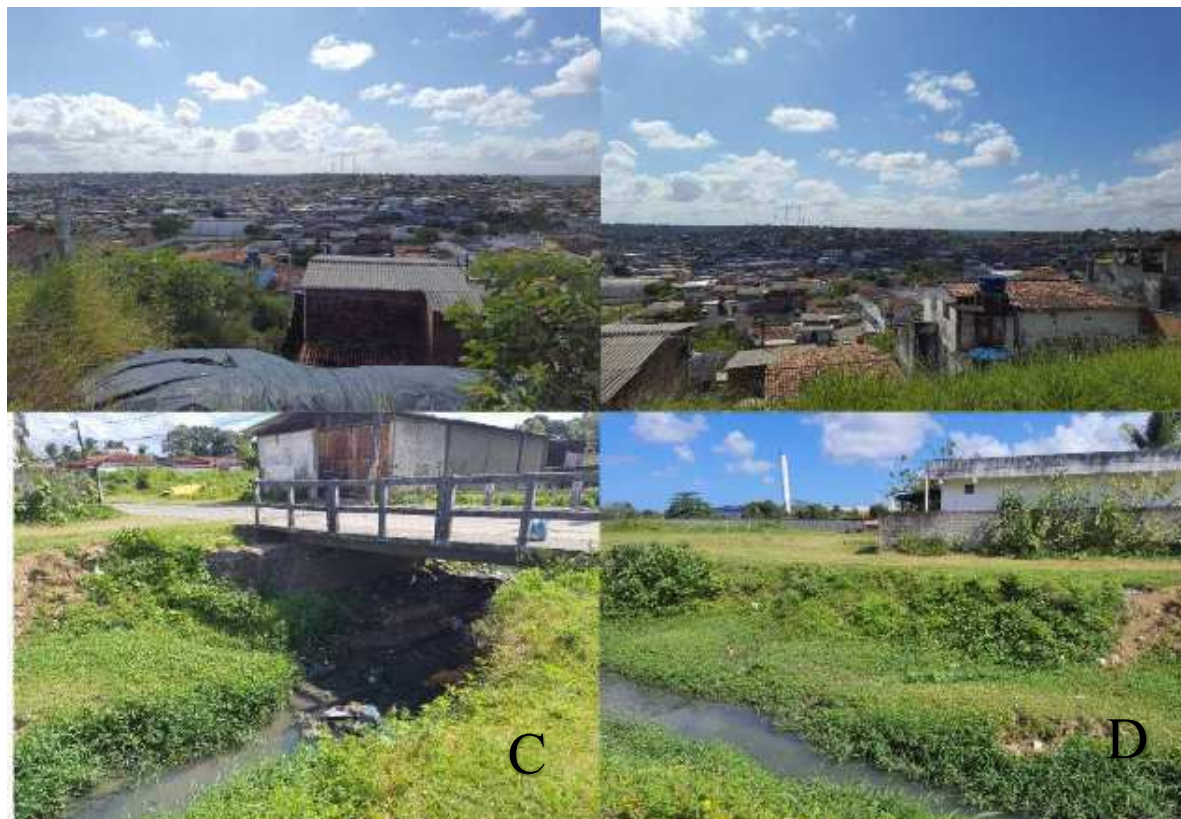
Figura 19 – Áreas entre 75 e 5 m na BHRT. Região densamente ocupada às margens da BR-101 (A e B); afluentes do Rio Timbó utilizados para o despejo de efluentes (C e D).
