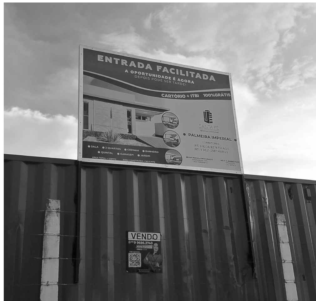
Fotografia 04: Novos condomínios em construção no bairro do Velame
