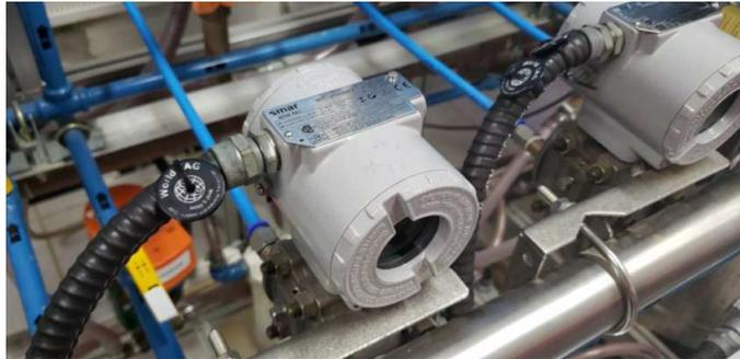
Esses sensores são usados para determinar o nível do tanque com base na diferença de pressão em uma coluna, conforme ilustrado na Figura 9. Para seu correto funcionamento, é necessário realizar calibrações, definindo o zero e o máximo da coluna. É importante ressaltar que cada tanque possui sua própria coluna.
