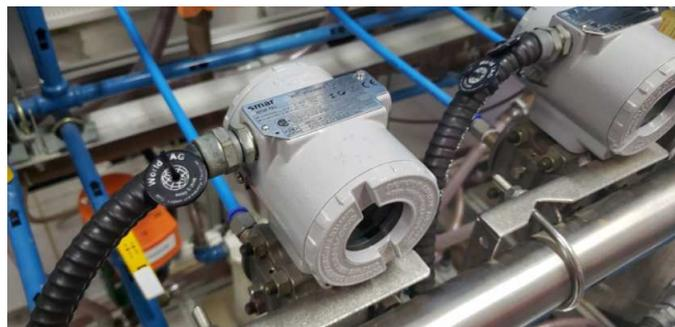
Esses sensores são usados para determinar o nível do tanque com base na diferença de pressão em uma coluna, conforme ilustrado na Figura 8. Para seu correto funcionamento, é necessário realizar calibrações, definindo o zero e o máximo da coluna. É importante ressaltar que cada tanque possui sua própria coluna.
