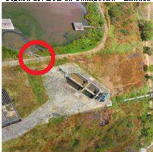
Figura 13: ETE da Catingueira – Entrada
