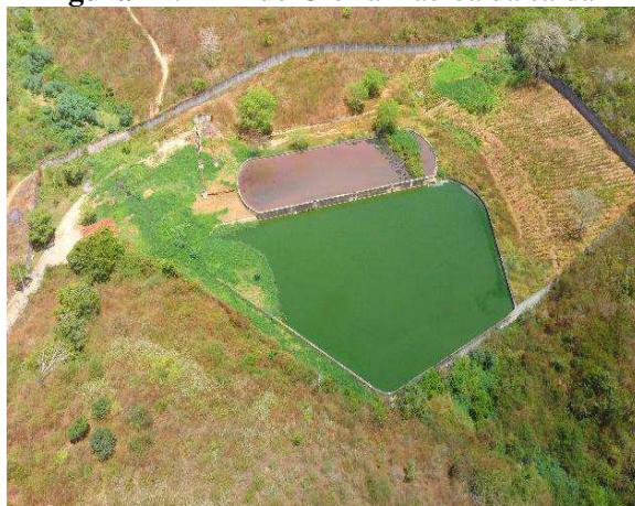
Figura 12: ETE do Glória – aérea da saída
