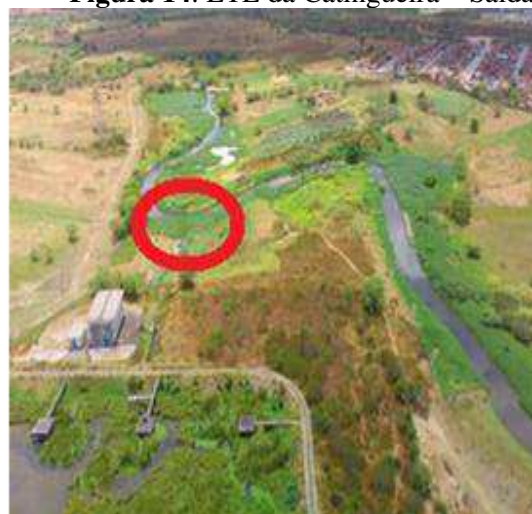
Figura 14: ETE da Catingueira – Saída
