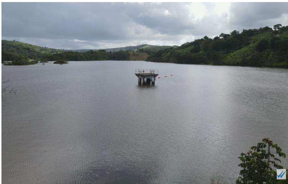
Figura 4: Barragem Canafístula II, localizada na zona rural de Borborema-PB.
