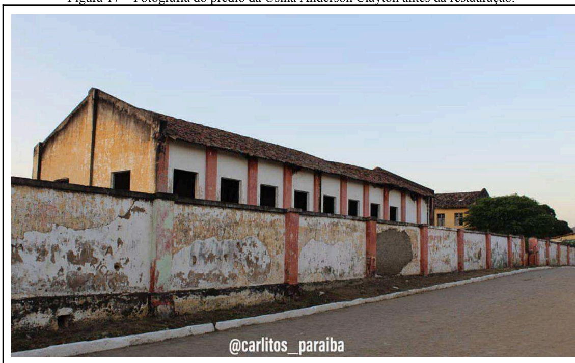
Figura 17 – Fotografia do prédio da Usina Anderson Clayton antes da restauração.
