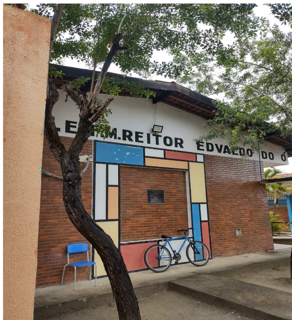
Figura 01: Fachada principal da Escola.
