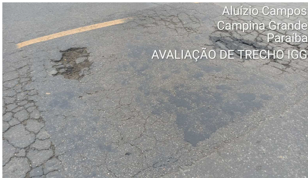
Figura 29 – Panela identificada no pavimento estudado.
