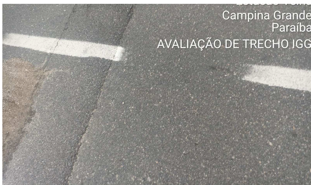
Figura 31 – Remendo identificado no pavimento estudado.
