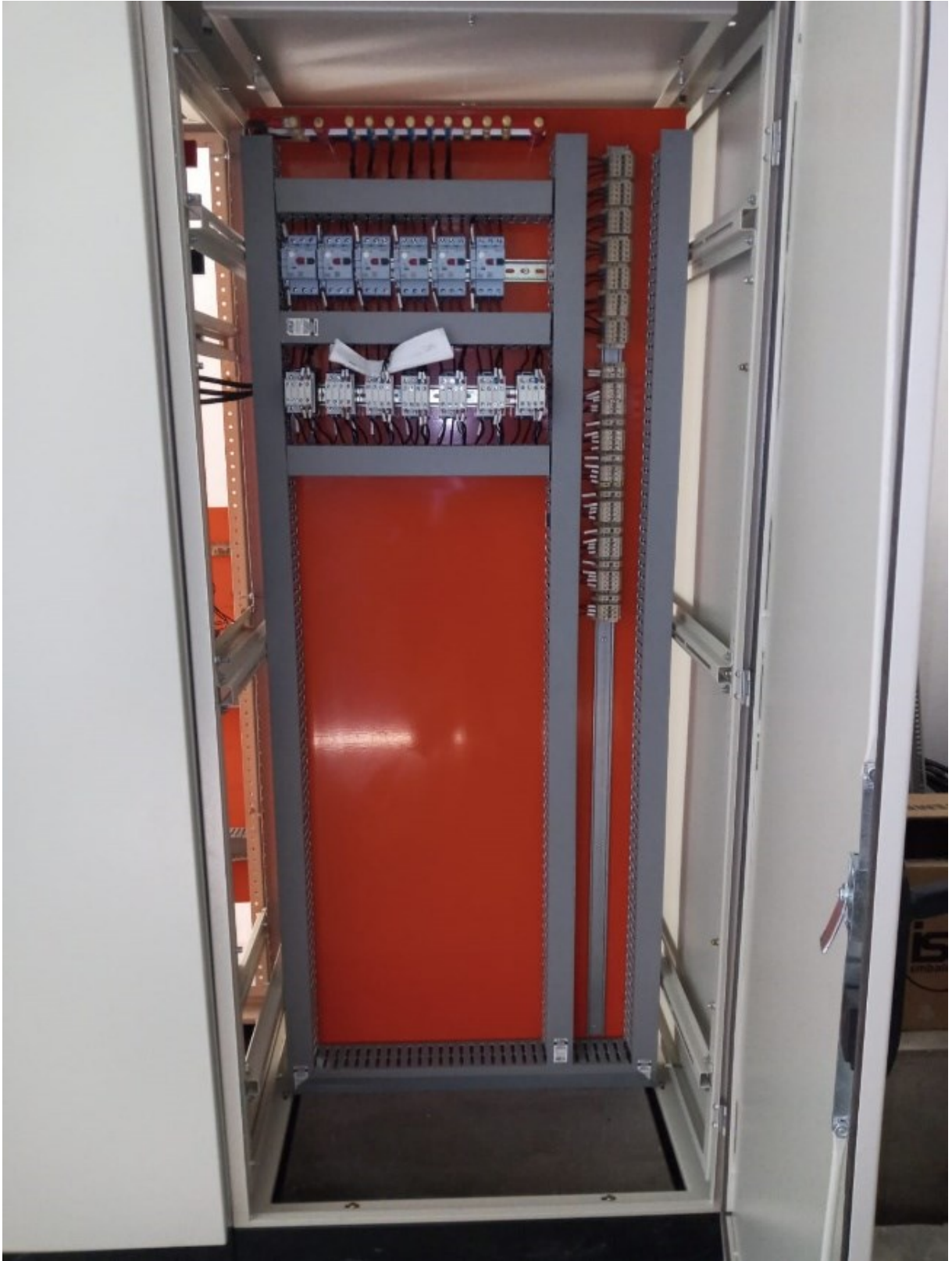
Figura 20 – Painel direito instalado
