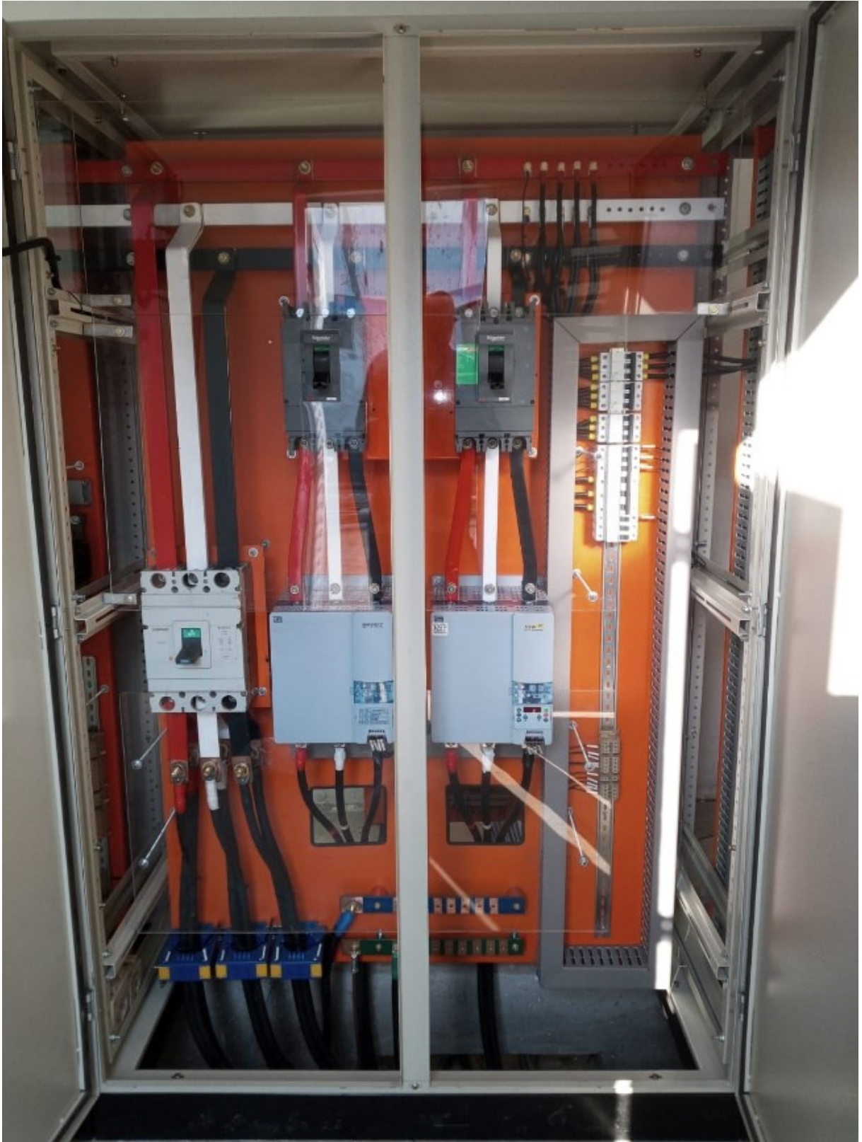
Figura 19 – Painel central instalado.
