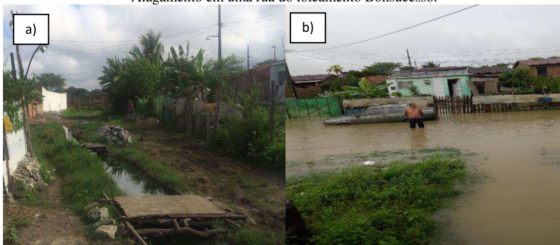
FIGURA 3: a) Loteamento Bonsucesso, Casas construídas às margens de um riacho. b) Alagamento em uma rua do loteamento Bonsucesso.
