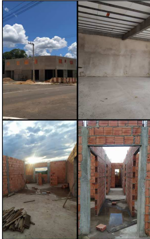
Figura 10 – Situação atual do edifício EMUC.
