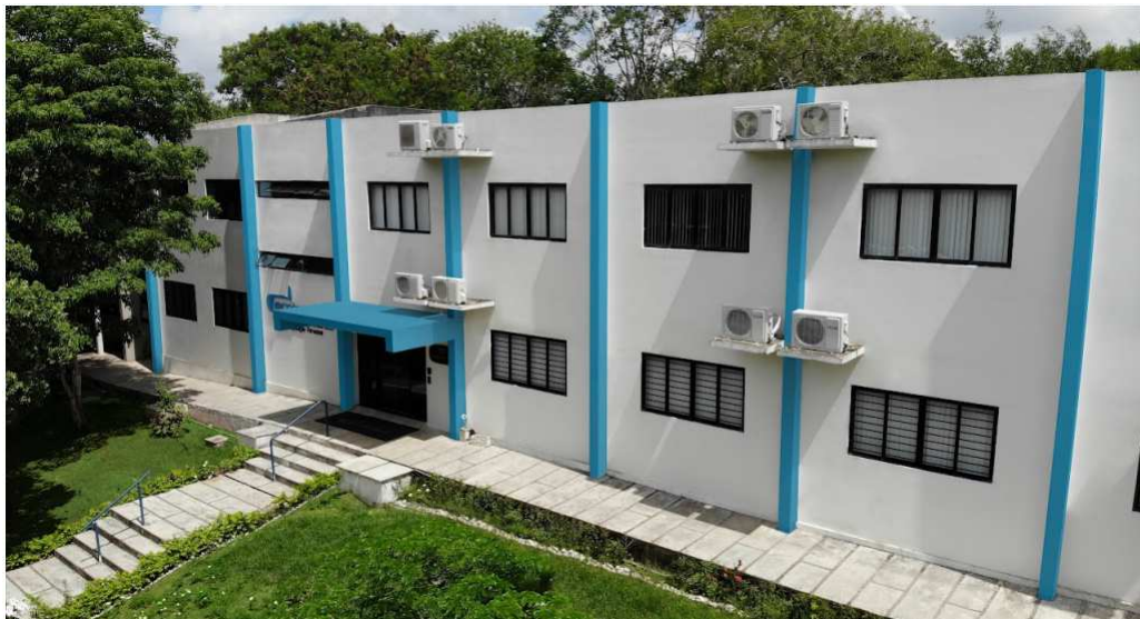
Figura 1 – Foto da fachada do prédio do Laboratório Embedded.
