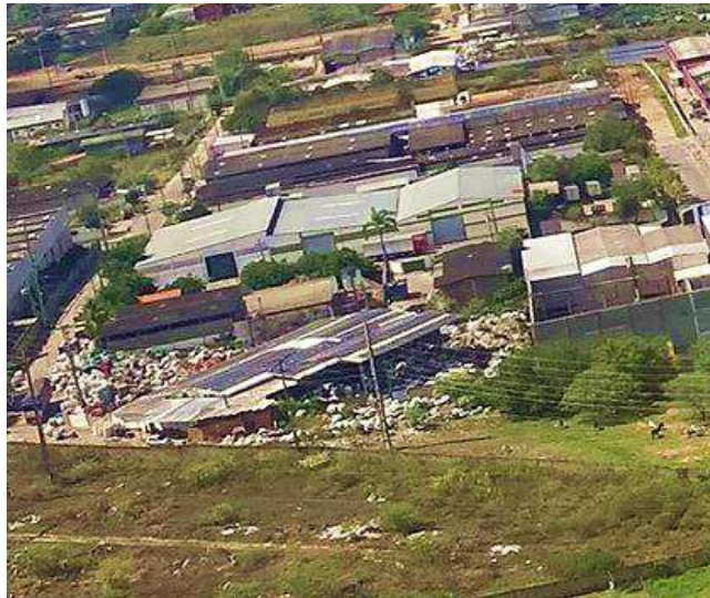
Figura 13 – Possível armazenagem irregular de resíduos nas proximidades do SBKG.
