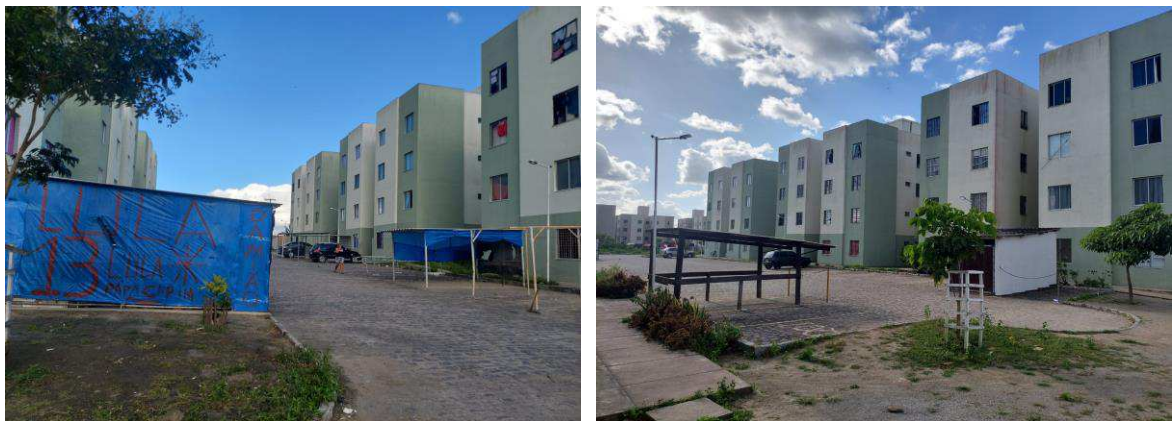
Figura 34: Garagens dos apartamentos.
