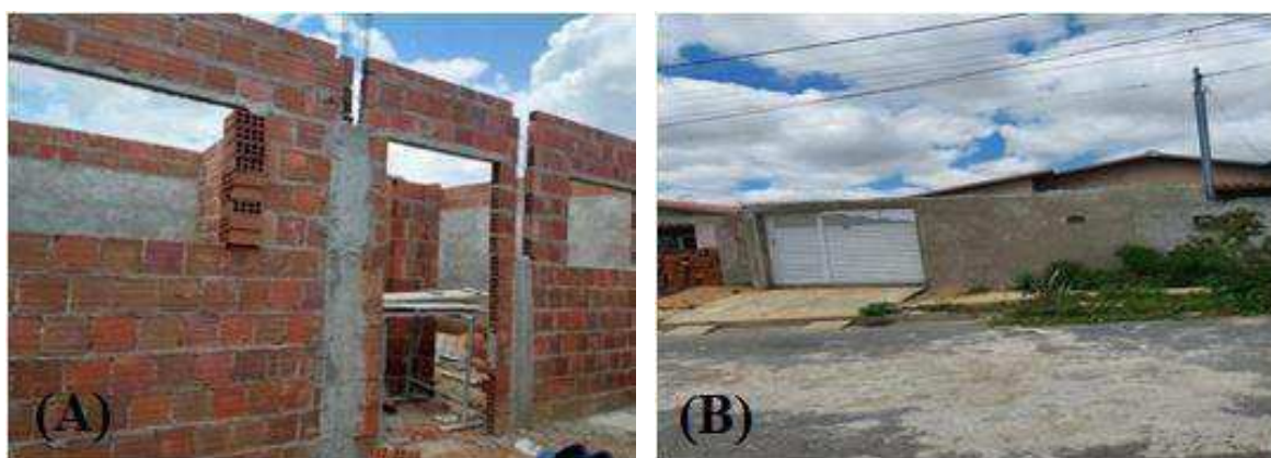
Figura 12: Construção do quarto nos fundos (A) do imóvel (B).
