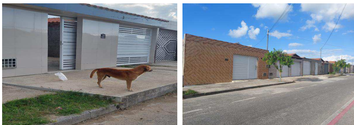
Figura 13: Muros e fachadas reformadas
