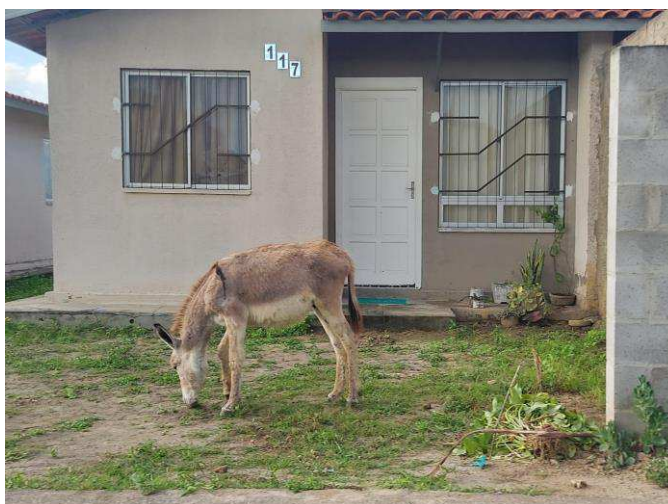
Figura 14: Fachada sem reformas.
