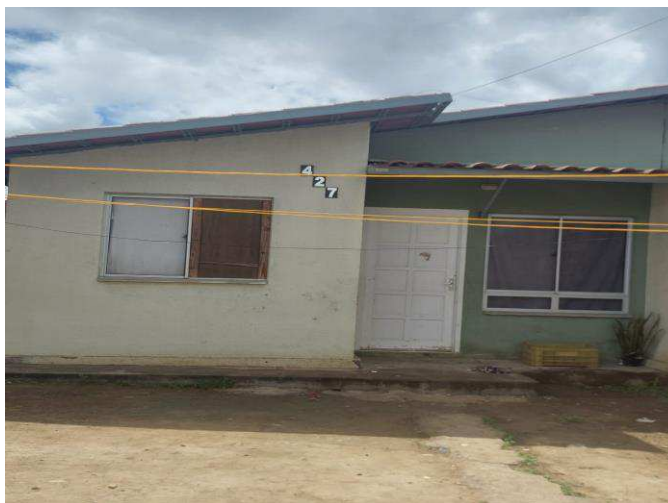
Figura 16: Fachada sem reformas.
