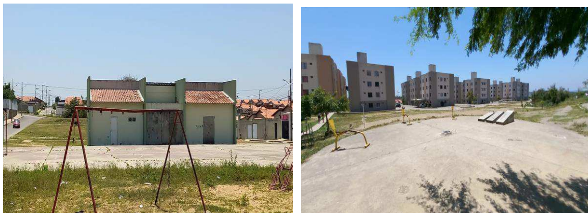
Figura 18: Parquinho e academia desativados.
