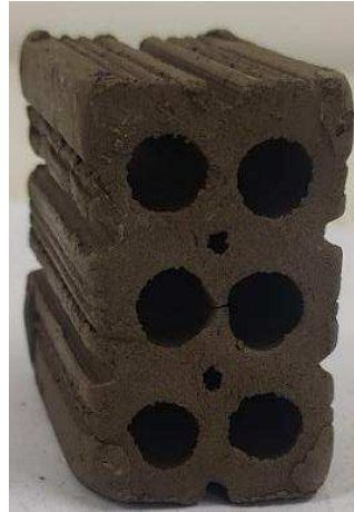
Figura 35 – Amostra com trinca no septo central.
