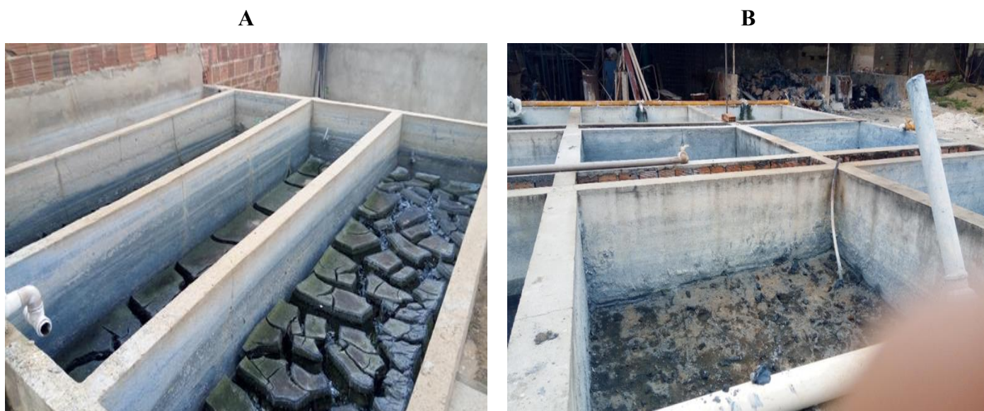
Figura 3 - Área destinado ao tratamento da água para reuso das lavanderias de pequeno (A) e médio porte (B). Retirada pela autora (2018).
