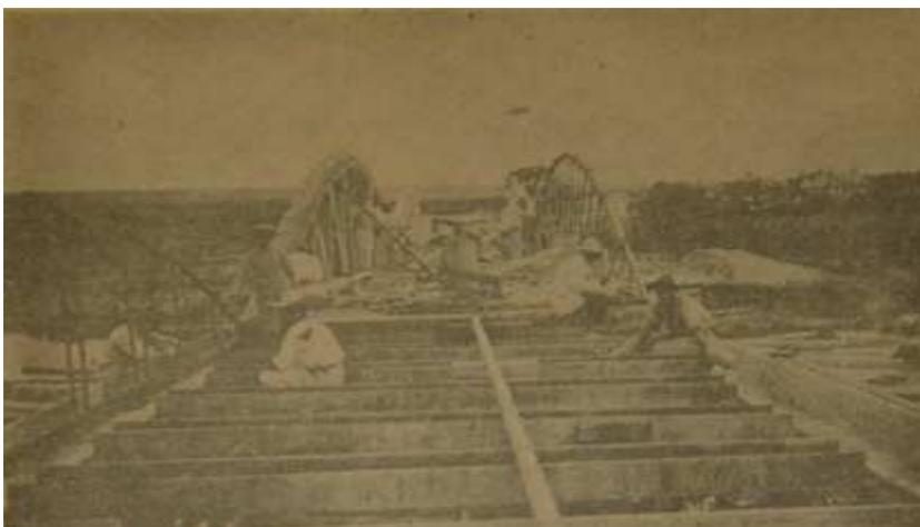
PONTE DE TAPEROÁ – Aspectos do trabalho de armação da ossatura metálica e das fôrmas de madeira para receber a argamassa de cimento. Fonte: *A União*, 31 maio 1925.
