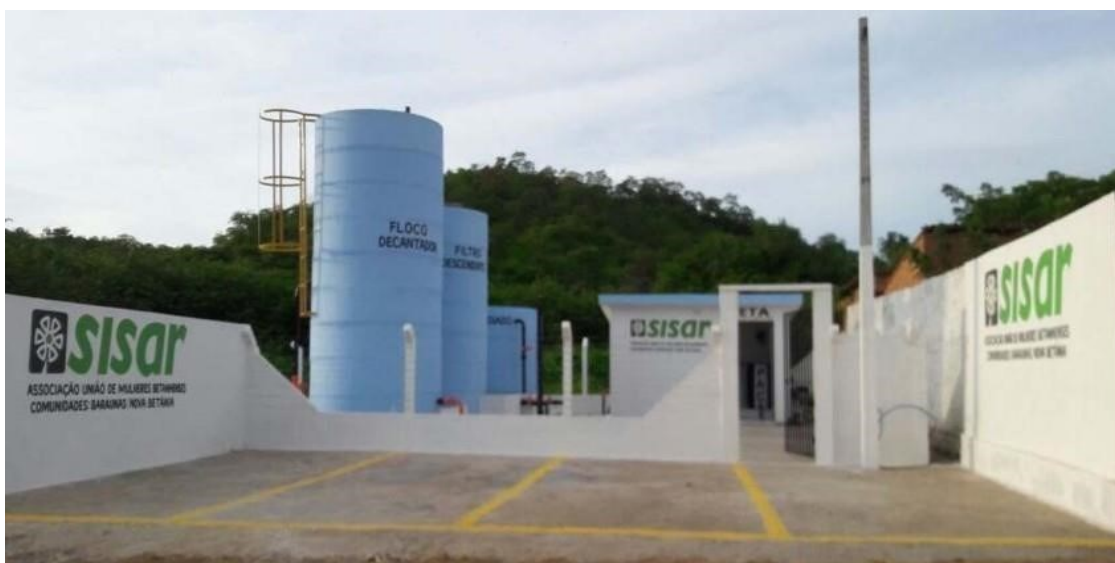
Figura 4 - Estação de Tratamento de Água do Sistema de Abastecimento de Água da comunidade Nova Betânia, localizada em Farias Brito-CE.
