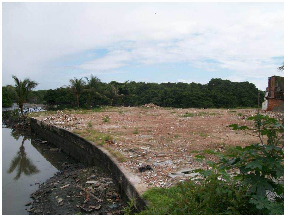
Figura 56: terreno onde se localizava a comunidade Xuxa logo após a demolição-2010. Fonte: Acervo do autor.
