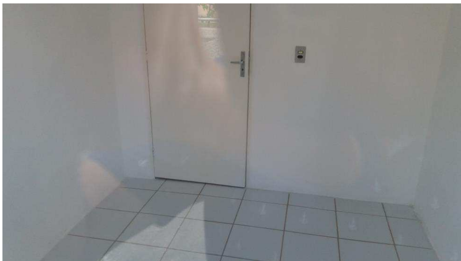
Figura 64: interior de um dos apartamentos do Habitacional Casarão do Barbalho, onde se pode ver os acabamentos internos de um dos quartos - 2019. Fonte: acervo do autor.
