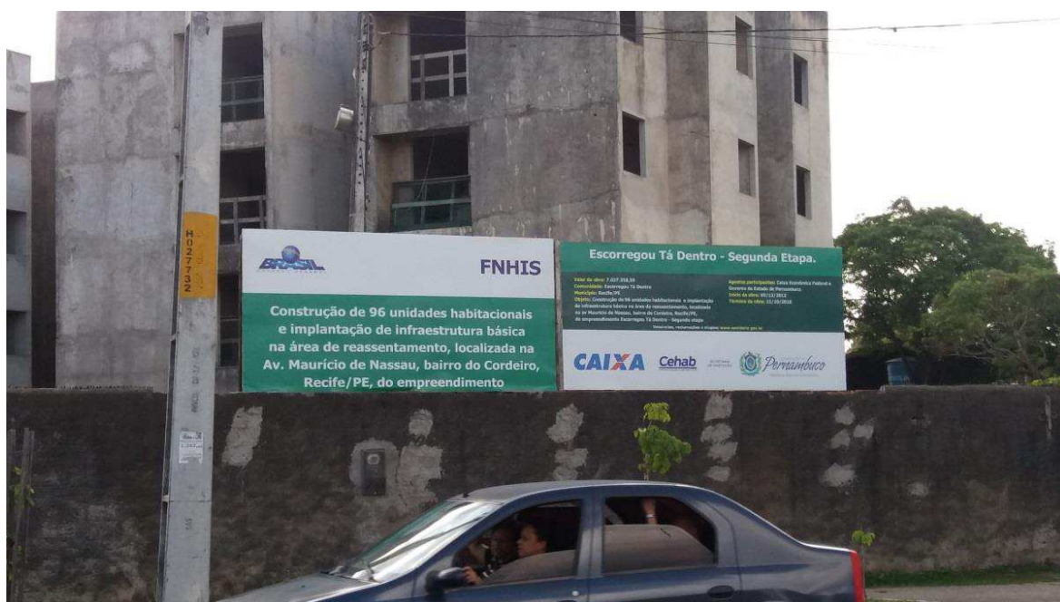
Figura 37: Placa da obra paralisada do Habitacional Escorregou Tá Dentro, em janeiro de 2019. Foto: Paulo Alexandre. Fonte: Acervo do autor
