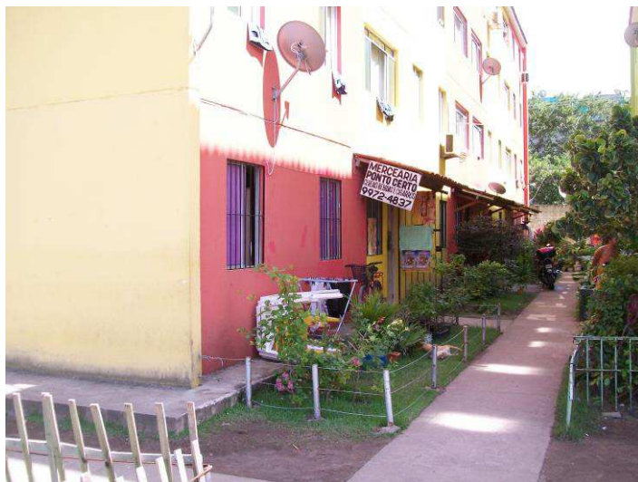
Figura 73: Apartamento térreo onde o morador compartilha a moradia com um estabelecimento comercial – 2013. Fonte: Acervo do autor
