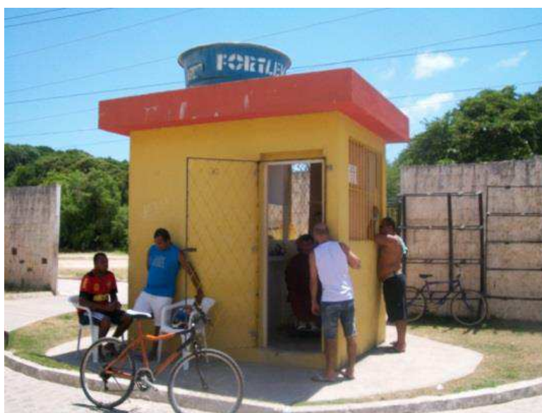
Figura 88: Barbearia instalada onde deveria ser a portaria do condomínio. Fonte: Acervo do autor.
