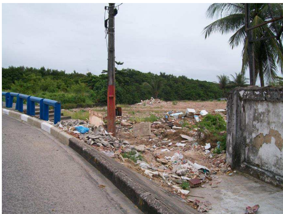
Figura 55: terreno onde se localizava a comunidade Xuxa logo após a demolição-2010. Fonte: Acervo do autor.
