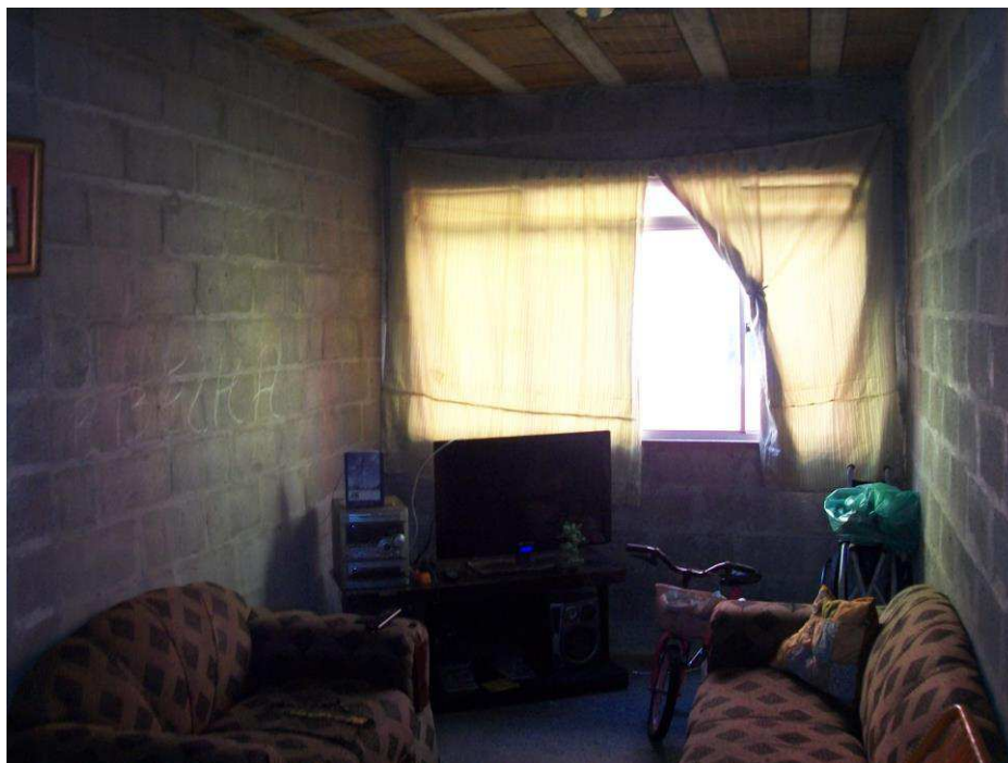
Figura 57: Sala de apartamento no Residencial III Via Mangue, entregue sem reboco.- 2013. Fonte: Acervo do autor.
