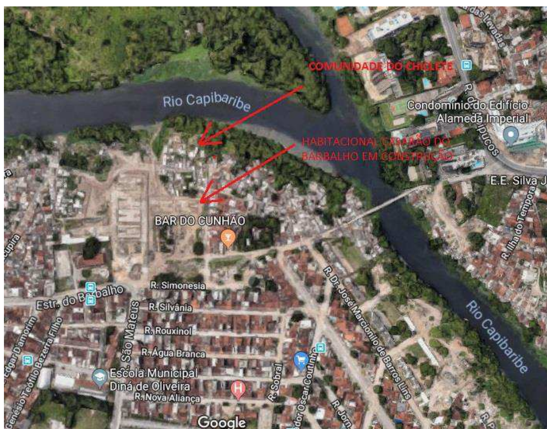
Figura 44: vista aérea da obra do Habitacional Casarão do Barbalho, ainda em construção, e da comunidade do Chiclete logo atrás - foto com data provável em 2013. Fonte: Google Maps
