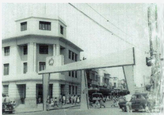
Figura 31 - Rua Maciel Pinheiro
