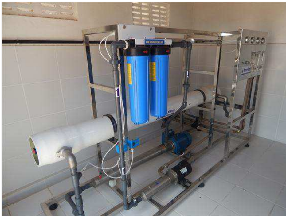
Figura 58 – Sistema de dessalinização da Escola Municipal de Ensino Fundamental Macário Zulmiro. Fonte: AUTOR, 2016.
