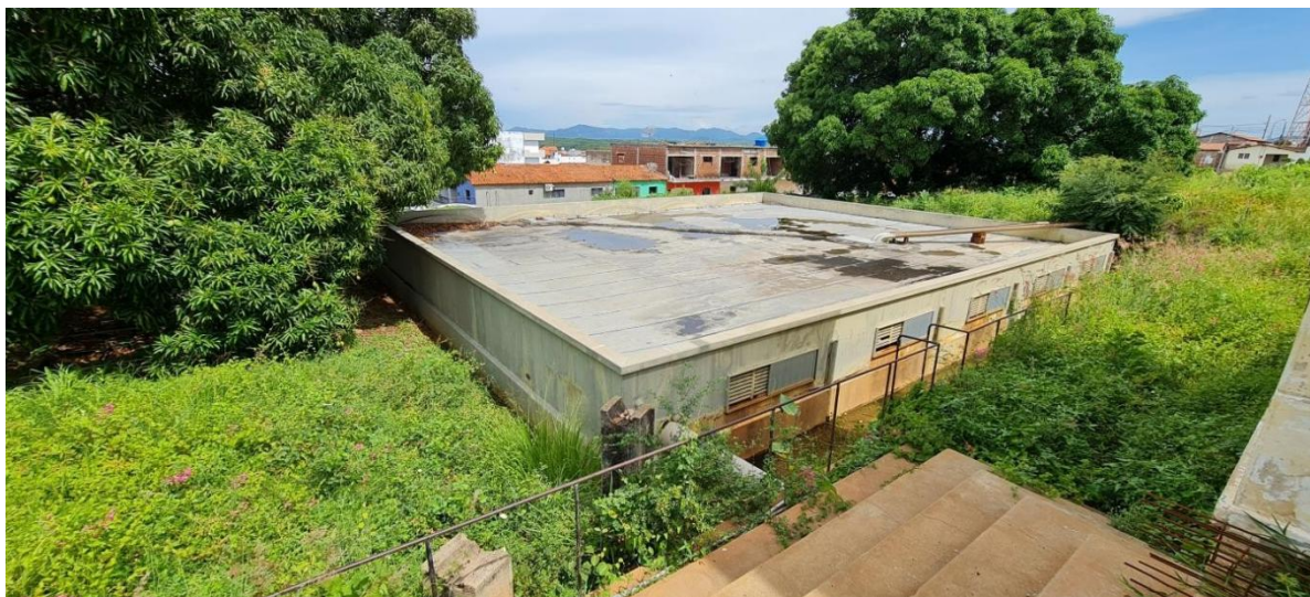
Figura 22 - Reservatório Apoiado (RAP) - R0
