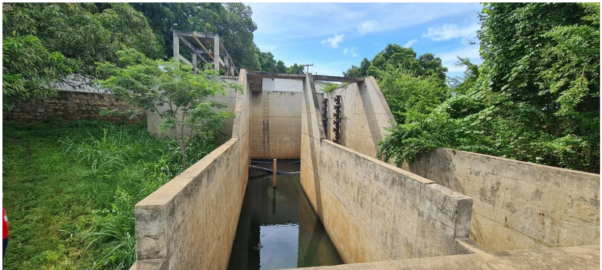
Figura 10 - Estrutura do Canal de aproximação da Captação de água do SAA de Pombal
