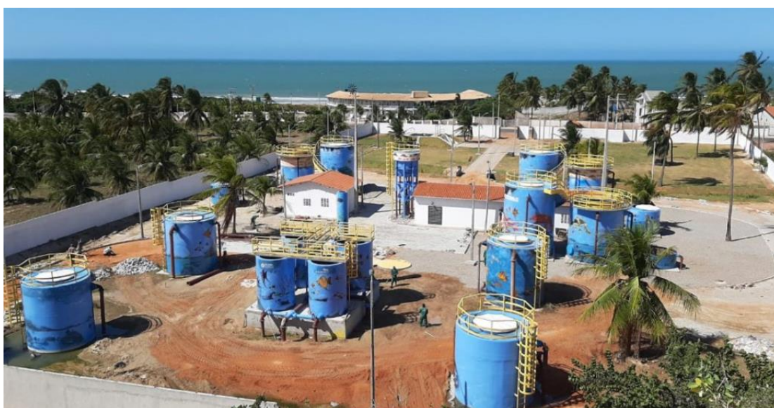
Figura 5 - Estação de tratamento de esgoto de Flecheiras/CE.
