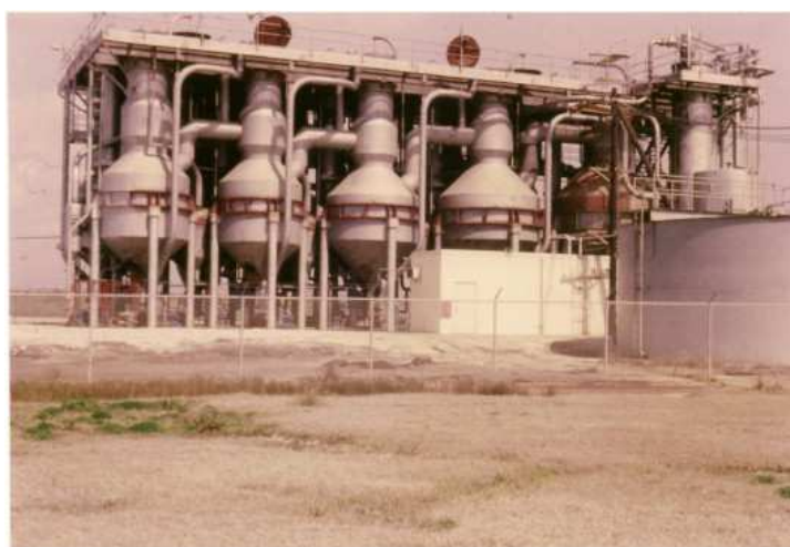
Figura 12 – Planta de múltiplos efeitos em Freeport, Texas.
