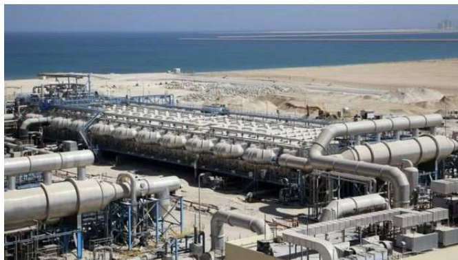
Figura 6 – Usina de dessalinização RO em Ras al-Khair Arábia Saudita com produção estimada de 1 bilhão de litros por dia.
