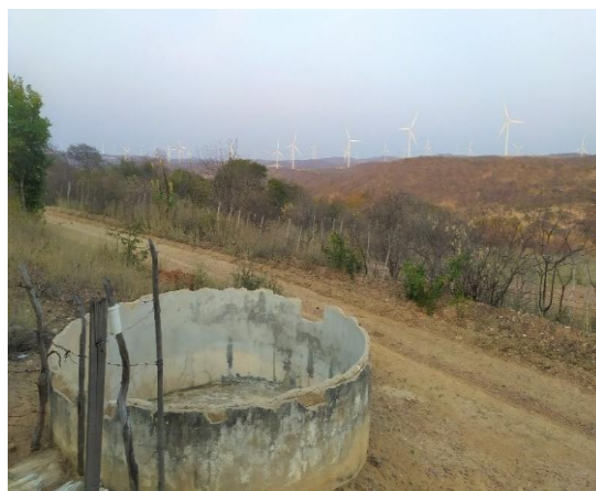
Figura 9 - Cisterna demolida diante das explosões na construção do parque eólico, essa já se encontrava sem os escombros, pois foi retirado pelo morador.
