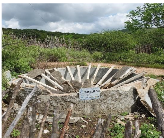
Figura 8 - Cisterna demolida de um dos moradores diante das explosões na construção do parque eólico.
