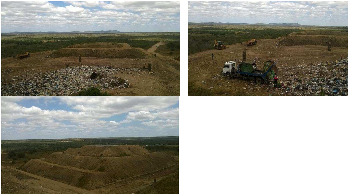
Figura 2. Disposição de resíduos pelos caminhões de lixo e setores concluídos.
