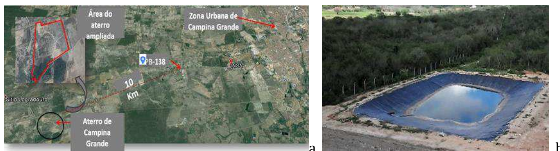
Figura 1. Aterro Sanitário em Campina Grande-PB: A) Localização; B) Lagoa de Tratamento de Lixiviado.
