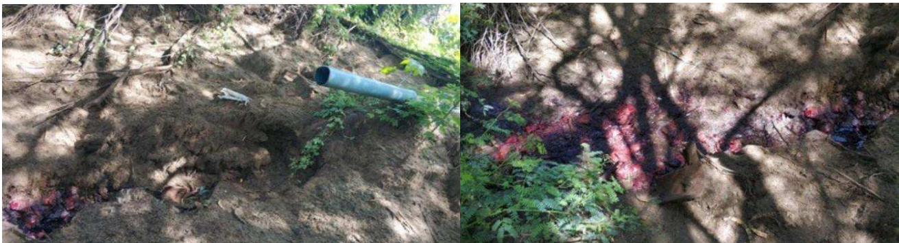
Figura 15.- Lançamentos de efluentes em SJC5
