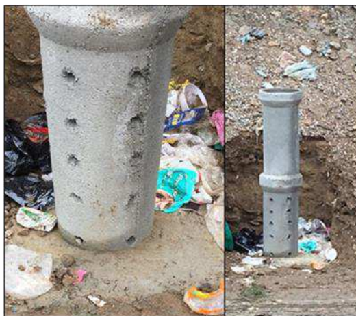
Figura 3. Novo modelo de piezômetro.
