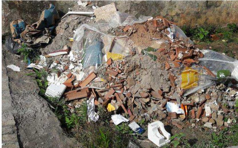
Figura 3. RCDs distribuídos na calçada, sem controle e seleção de materiais.
