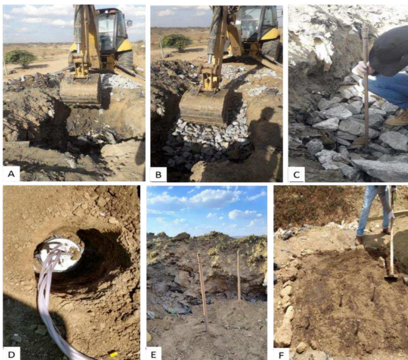
Figura 25. Etapas da instalação da Bio1 no Aterro Sanitário.
