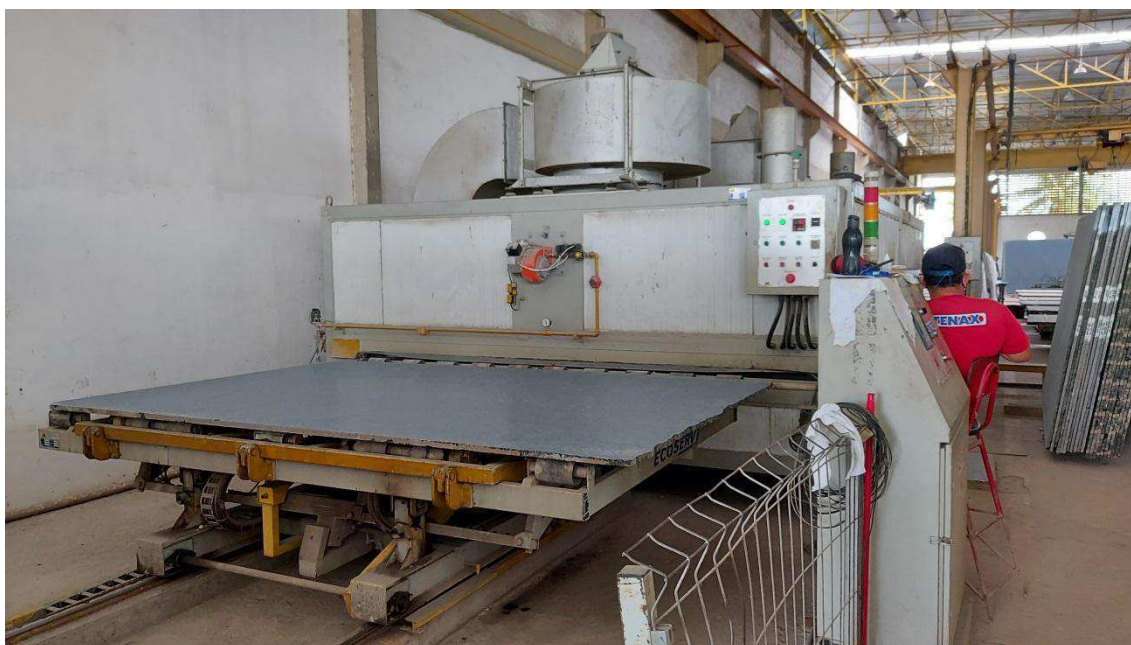
Figura 54: Chapa na entrada do Forno. Fonte: Autor.
