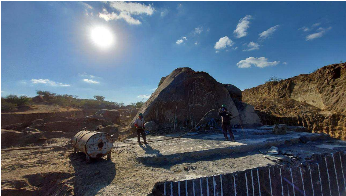
Figura 37: Pedreira com método de Lavra de Matacões. Fonte: Autor, 2020
