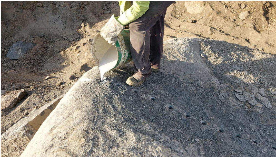
Figura 41: Aplicação de massa expansiva para corte de matacão. Fonte: Autor, 2020
