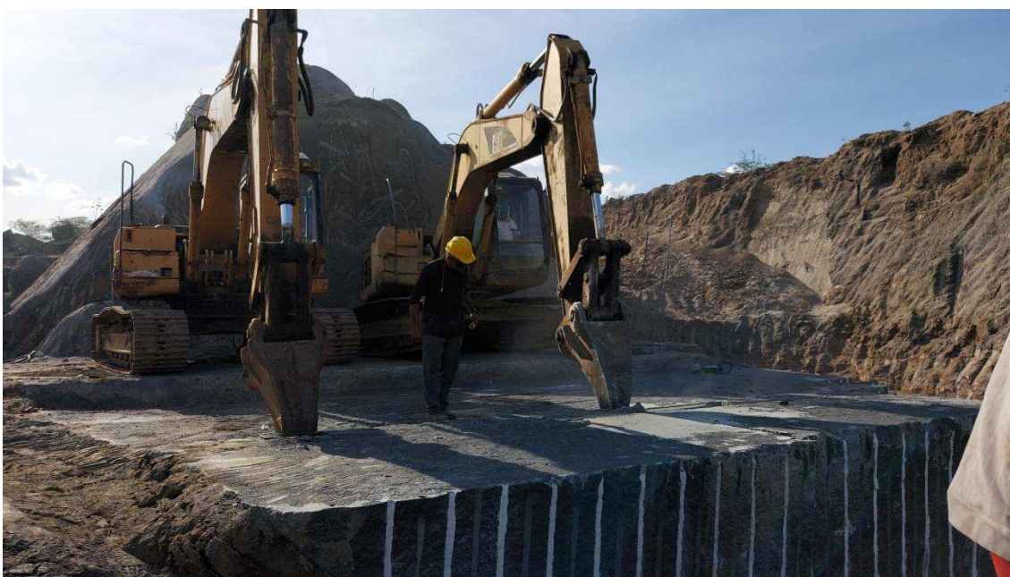
Figura 47: Retroscavadeiras equipadas com o "Unhão" para tombamento de prancha. Fonte: Autor, 2020.
