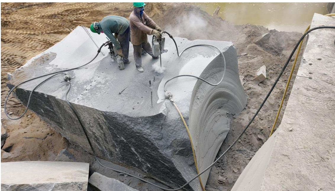
Figura 42: Perfuração para corte com cunhas em prancha. Fonte: Autor, 2020.
