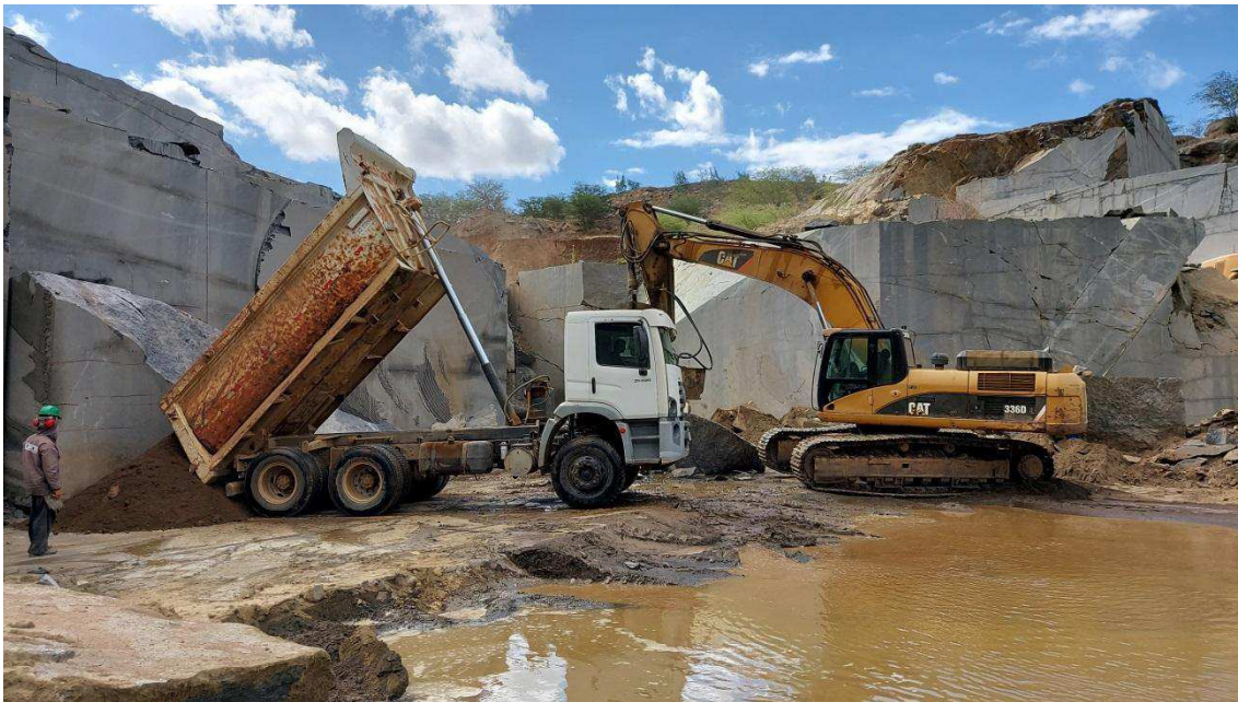
Figura 44: Preparação da "Cama" antes do tombamento da prancha. Fonte: Autor, 2020.
