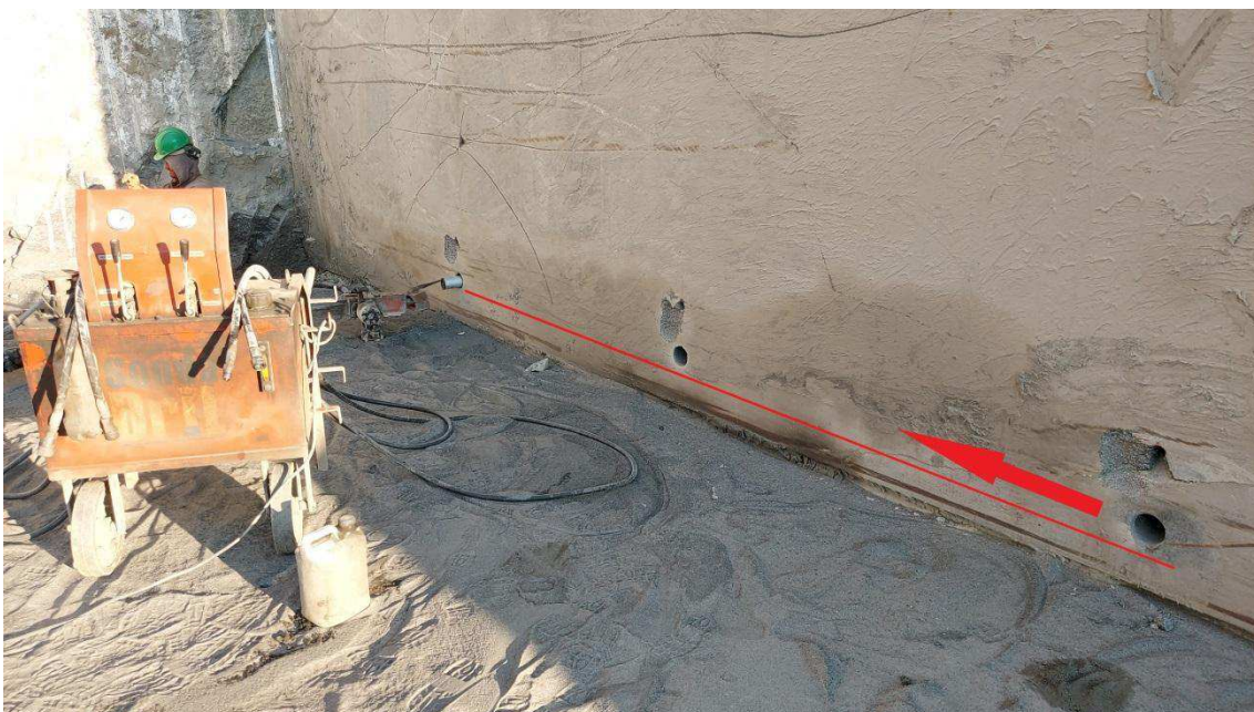
Figura 38: Corte de levante feito com Fio-diamantado. Fonte: Autor, 2020.
