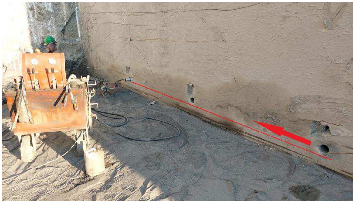
Figura 21: Corte de levante feito com Fio-diamantado. Fonte: Autor, 2020.
