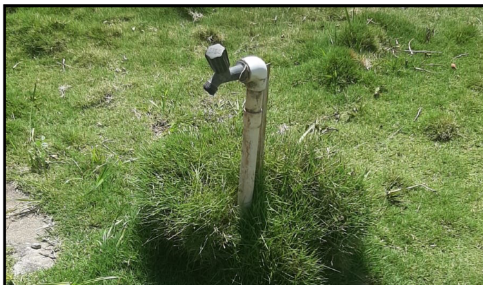
Figura 34 – Torneira externa conectada diretamente ao sub-ramal
