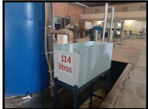
Figura 12 – Caixa para medição da vazão volumétrica
