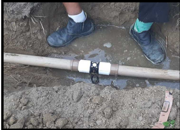
Figura 18 – Macromedidor instalado na rede
