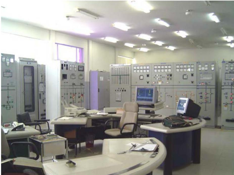
Figura 10: Sala de comando de subestação
