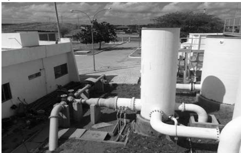
Foto: 3: Entradas d'água da adutora do Congo e da adutora de engate rápido do açude Sumé. Fonte: Acervo particular do autor
