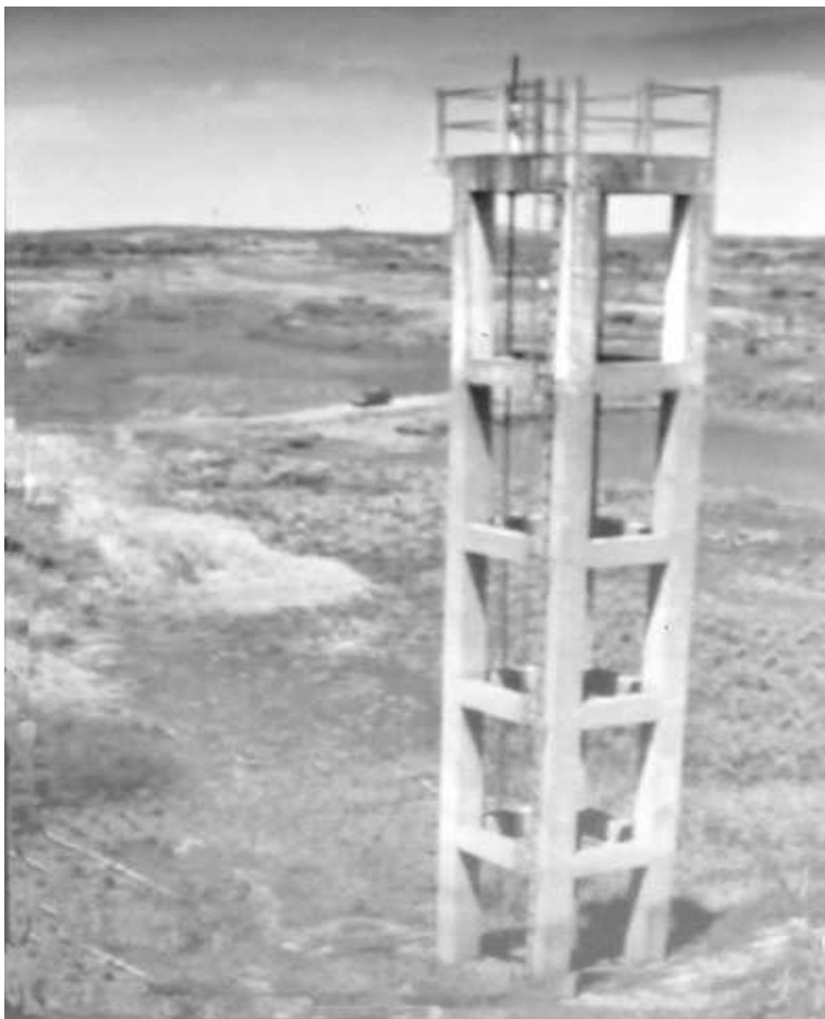
Foto 3: Açude de Sumé totalmente seco.
