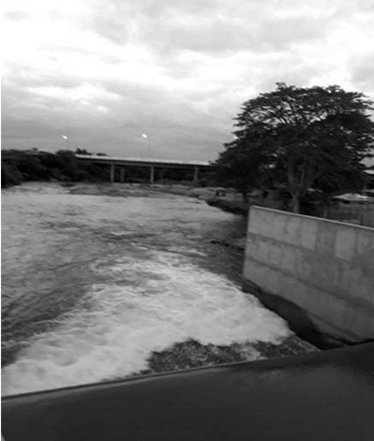
Foto 4: Canal da transposição descarregando no Rio Paraíba em Monteiro. Fonte: Acervo particular do autor.
