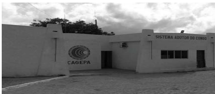
Foto 1: Sistema adutor do Congo – Bairro de Mandacarú – Sumé. Fonte:
