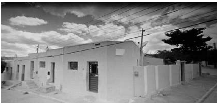
Foto 1 – Rua João Pereira de Amorim, os cabos da Energia ainda tem a mesma emenda. Fonte: Acervo do autor.
