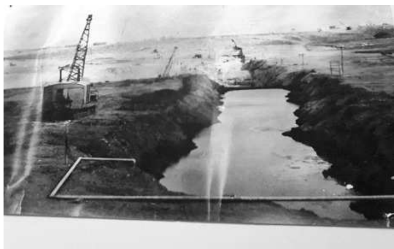
Fonte 1 e 2 - Escavações das fundações ao longo do eixo da barragem observam-se três dragas e tubulações para bombeamento.
