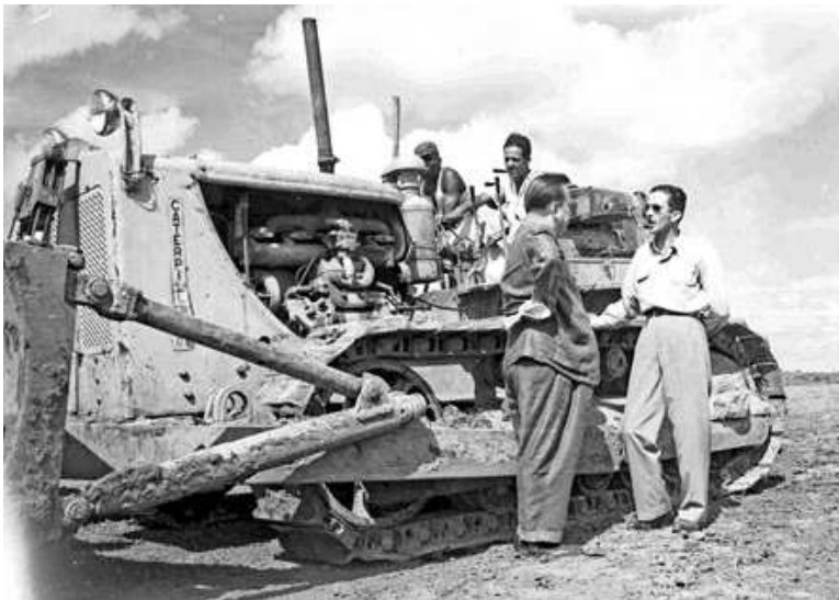
Foto 3: Trator de esteiras sem hidráulicos, todo movimento de levantar e baixar a lâmina é feito por um sistema de cabos de aço e pelo próprio peso da lâmina. FONTE: Acervo particular de Maria de Lourdes Machado.
