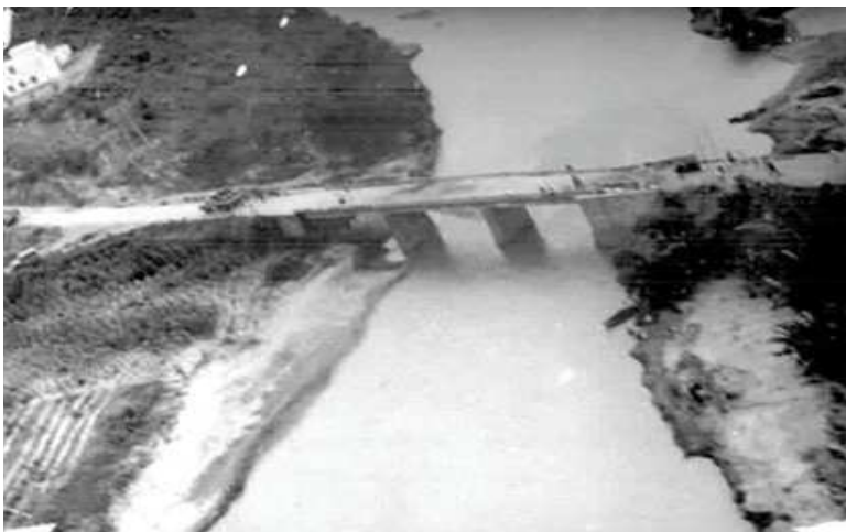
Foto 1: Ponte de Sumé – 1967. Mostra uma das cabeças arriada.
