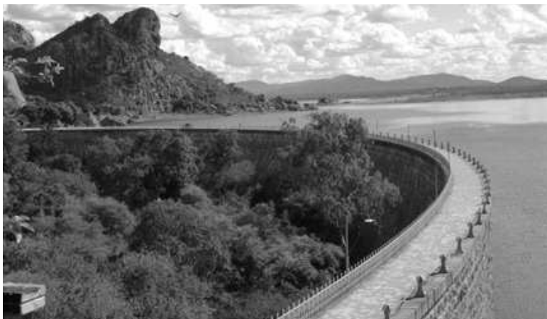
Foto 4 – Açude Cedro - CE – Iniciado em 1890 e concluído em 1906 Fonte: Domínio Público
