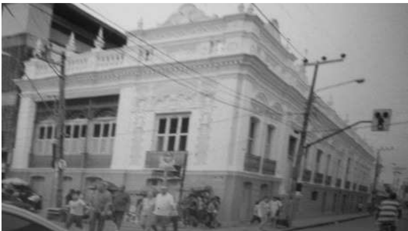
Foto 5 - Rua:General Sampaio com a Pedro Pereira - Fortaleza – Sede do IOCS – incendiada em 01/12/1912 Fone: http://cpdoc.fgv.br
