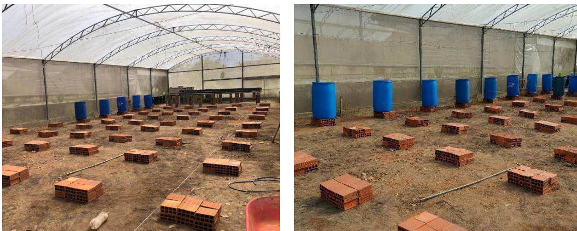
Figura 2. Instalação das bases para sustentação dos lisímetros
