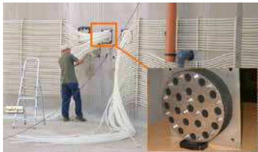
FOTO 49 | Instalação do sistema de aquecimento central de Reatores de Mistura Contínua.
