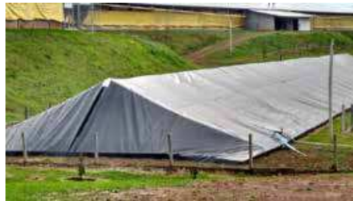
FOTO 05 | Cisterna em funcionamento.
