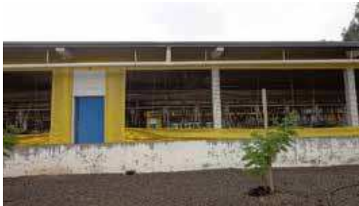
FOTO 02 | Vista lateral de um pavilhão de maternidade com o sistema de captação da água da chuva.
