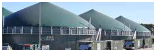
FOTO 48 | Reatores de Mistura Contínua
