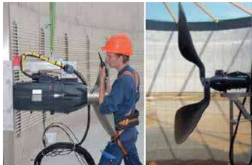
FIGURA 13 | Instalação dos agitadores submersos.
