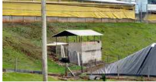
FOTO 03 | Pavilhão de recria com sistema de captação e sistema de filtragem da água da chuva.
