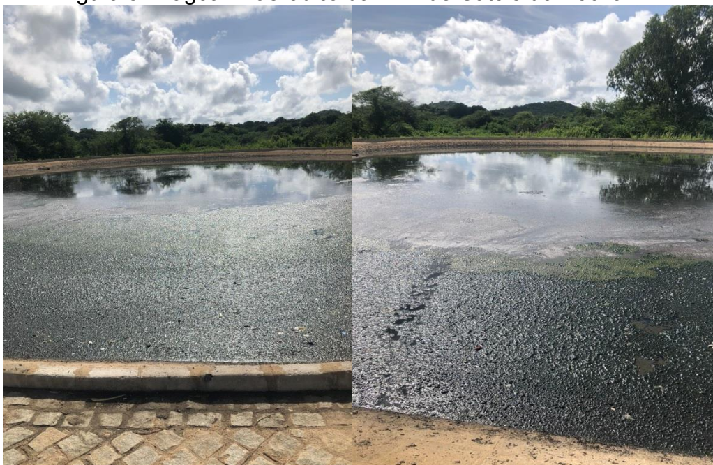
Figura 8 - Lagoa Anaeróbica da ETE de Catolé do Rocha-PB.
