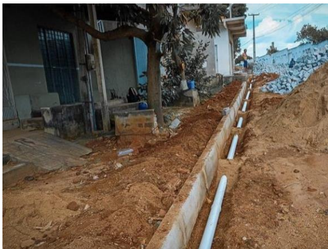
Figura 11 - Instalação de rede doméstica de esgoto executada pela SEINFRA de Catolé do Rocha-PB.
