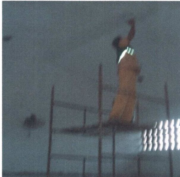
Figura 25 - Emassamento de teto
