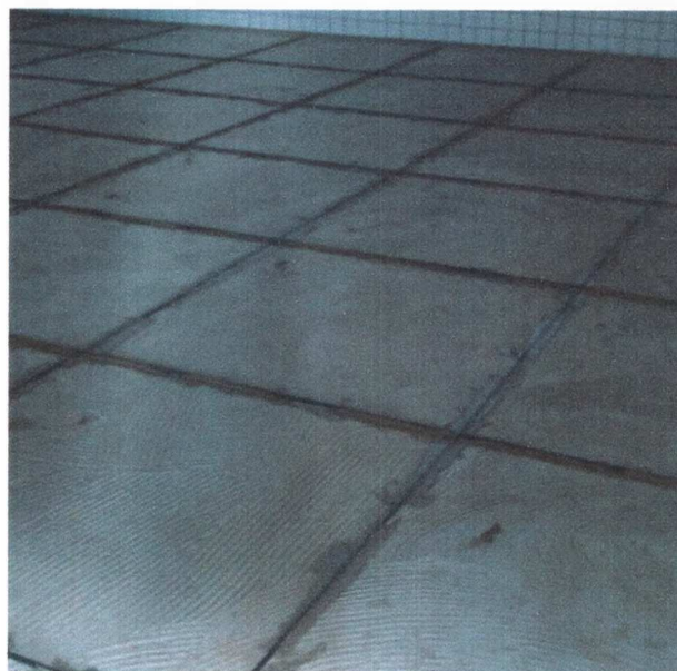
Figura 22 - Camada de base aderente com juntas
