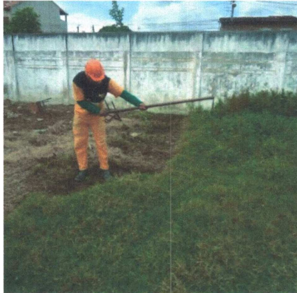
Figura 8 - Limpeza manual do terreno
