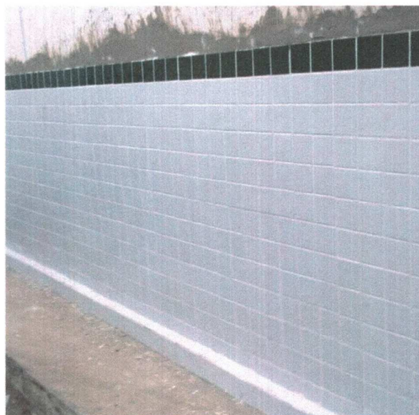
Figura 19 - Assentamento de pastilhas cerâmicas
