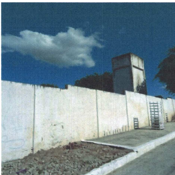
Figura 14 - Muro externo com pintura cal
