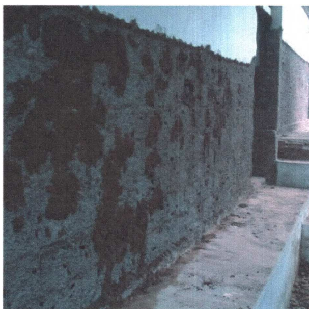
Figura 17 - Camada de chapisco sobre alvenaria
