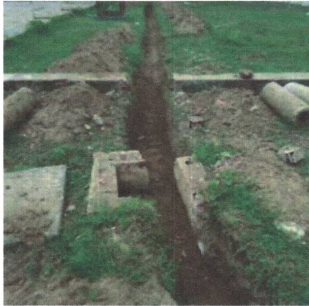
Figura 122 - Escavação de valas para troca de manilhas
