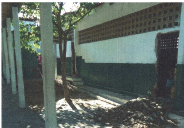
Figura 5 - Demolição de revestimento de alvenaria
