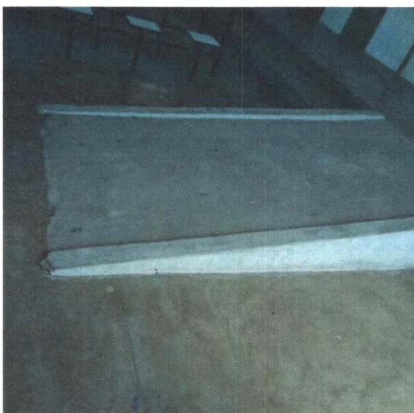
Figura 15 - Rampa de Acesso do refeitório
