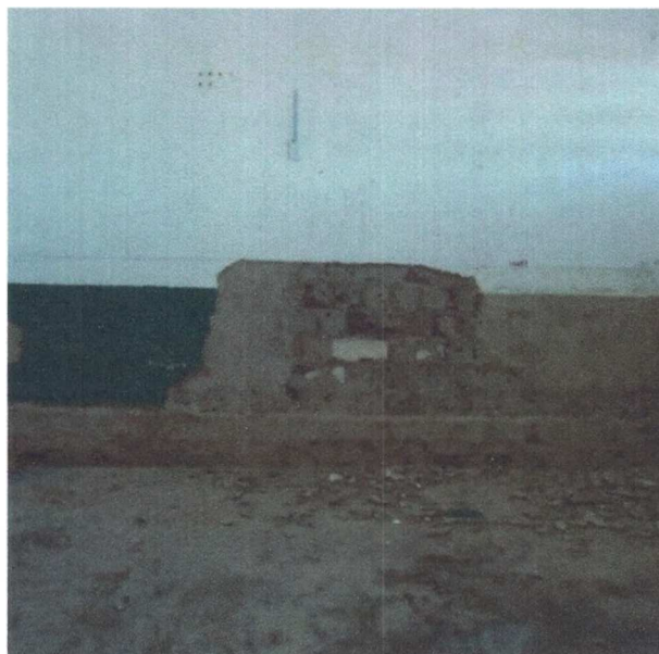
Figura 7 - Demolição de revestimento de paredes e piso
