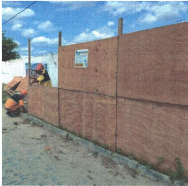
Figura 4 - Colocação de tapume
