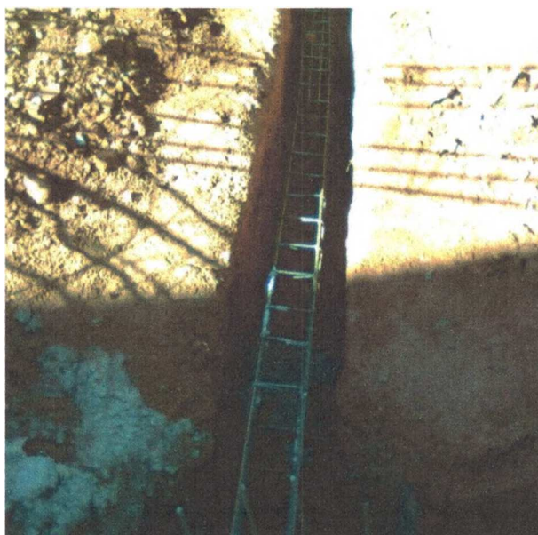
Figura 111 - Vala e armadura para cinta de amarração
