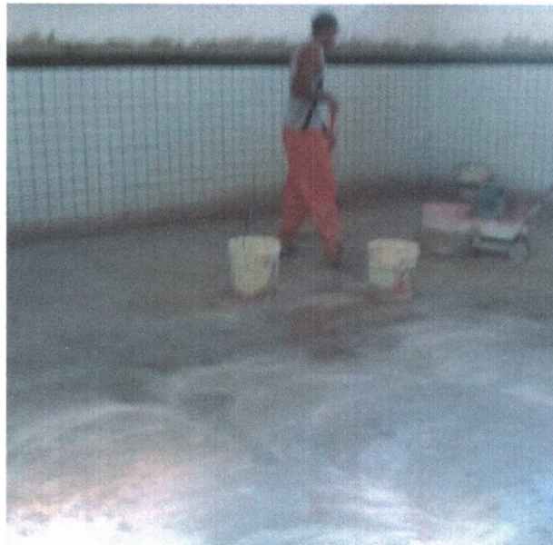
Figura 23 - Polimento de piso granilite
