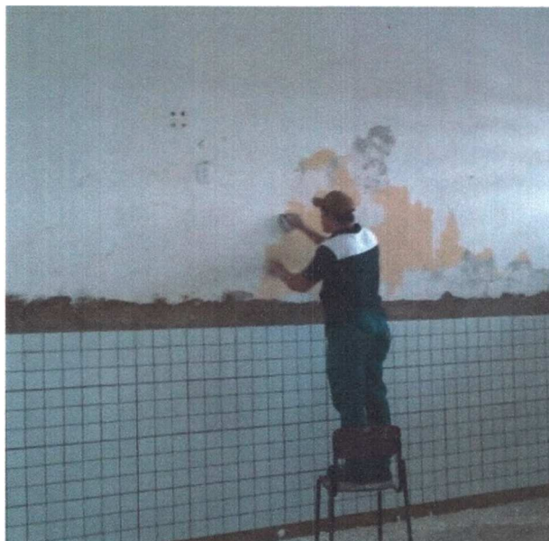
Figura 24 - Raspagem de pintura PVA
