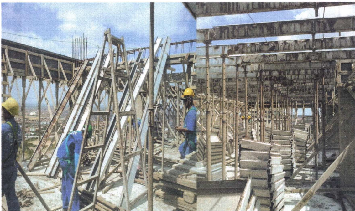
Figura 5 - Colocação das calhas ecubetas do fundo da laje.
