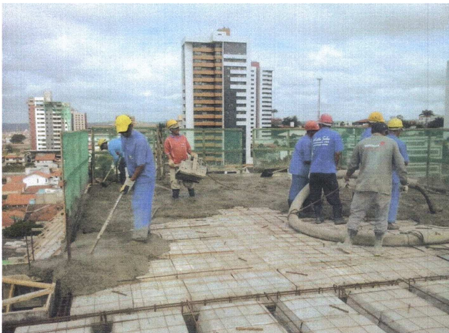
Figura 8 - Concretagem de vigas e lajes
