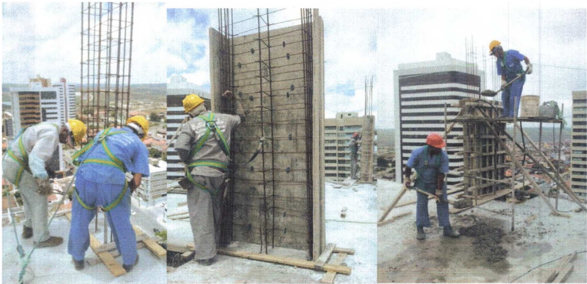
Figura 9 - Etapas de montagem e concretagem de pilares
