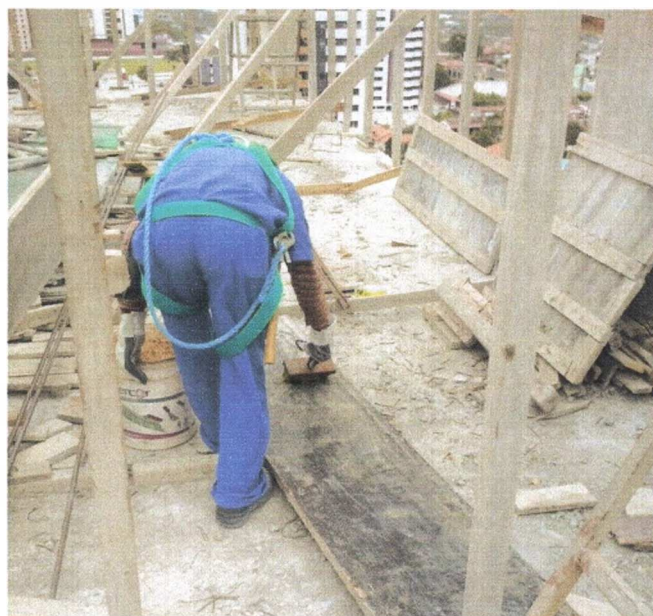
Figura 6 - Aplicação de desmoldante em fôrmas.
