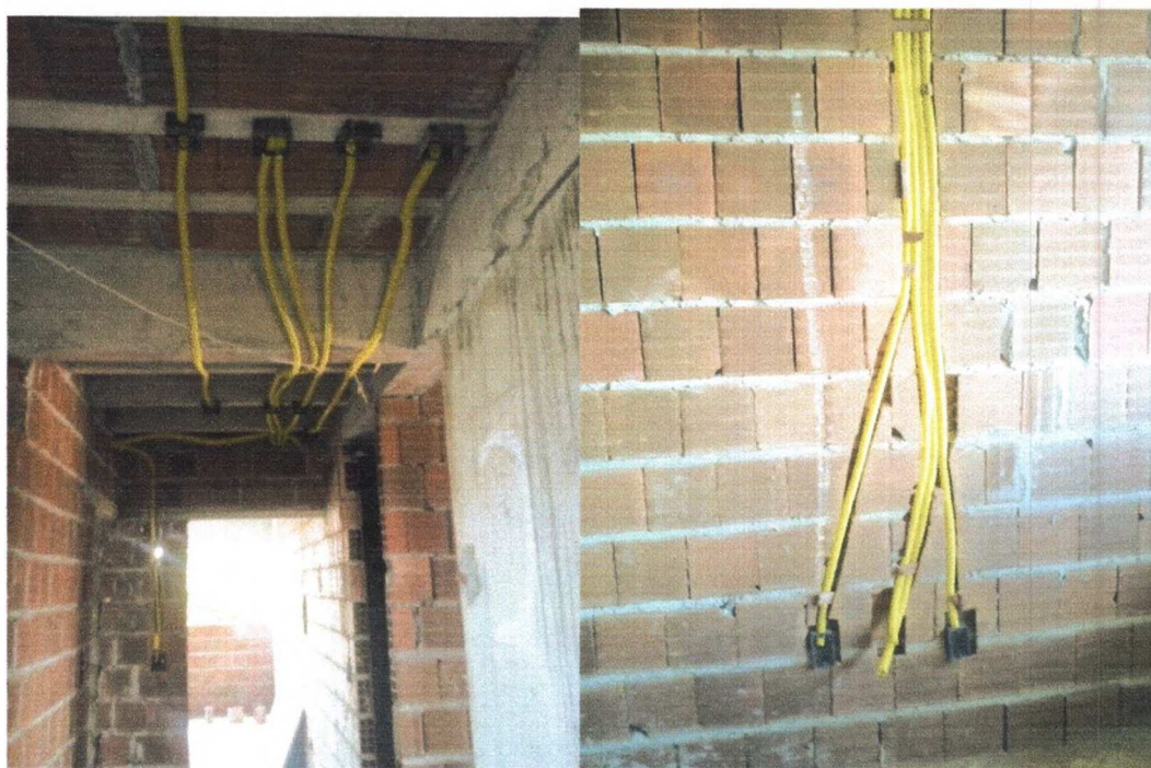
Figura 12 - Montagem das instalações elétricas
