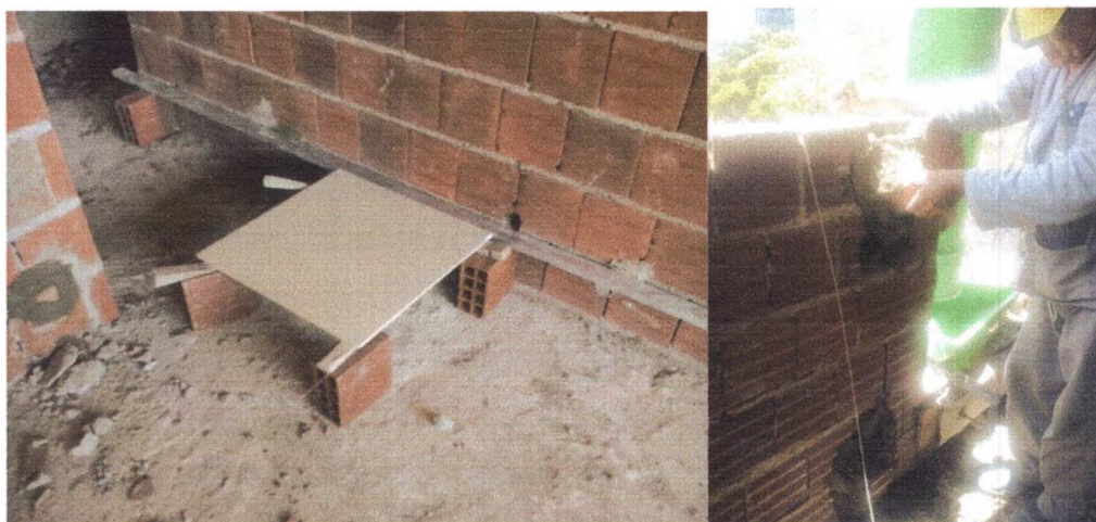
Figura 13 - Verificação de esquadro e emestramento
