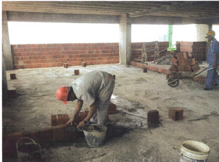
Figura 10 - Marcação de alvenaria
