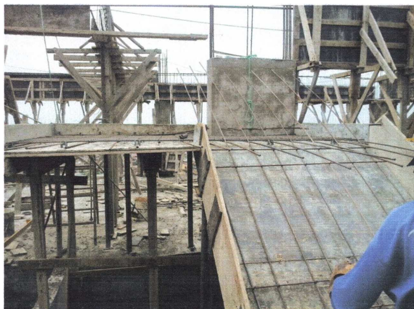
Figura 7 - Armação de ferragem.
