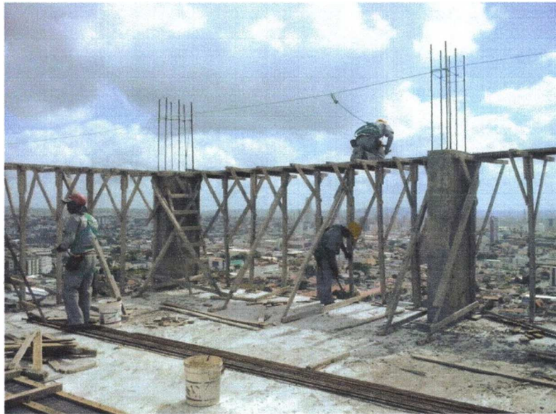
Figura 4 - Montagem das fôrmas de vigas
