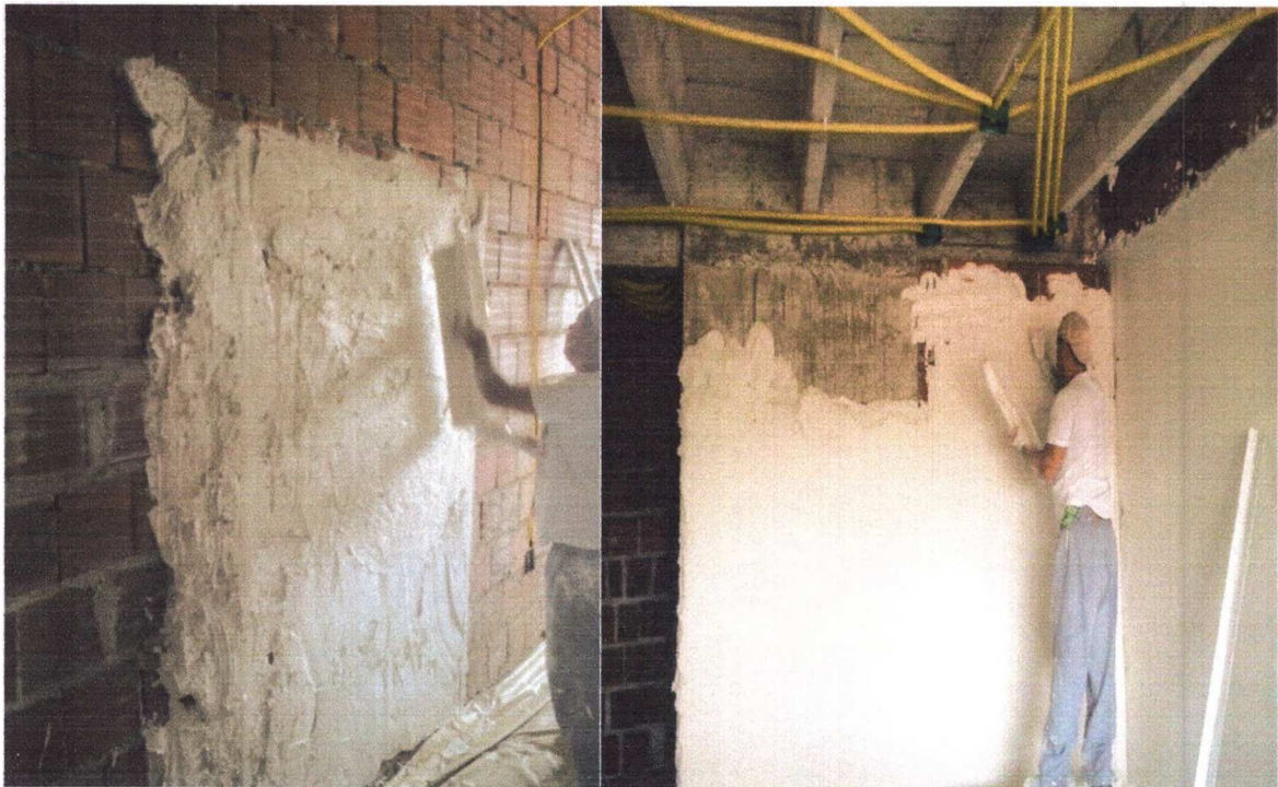
Figura 14 - Reboco em massa única de gesso.
