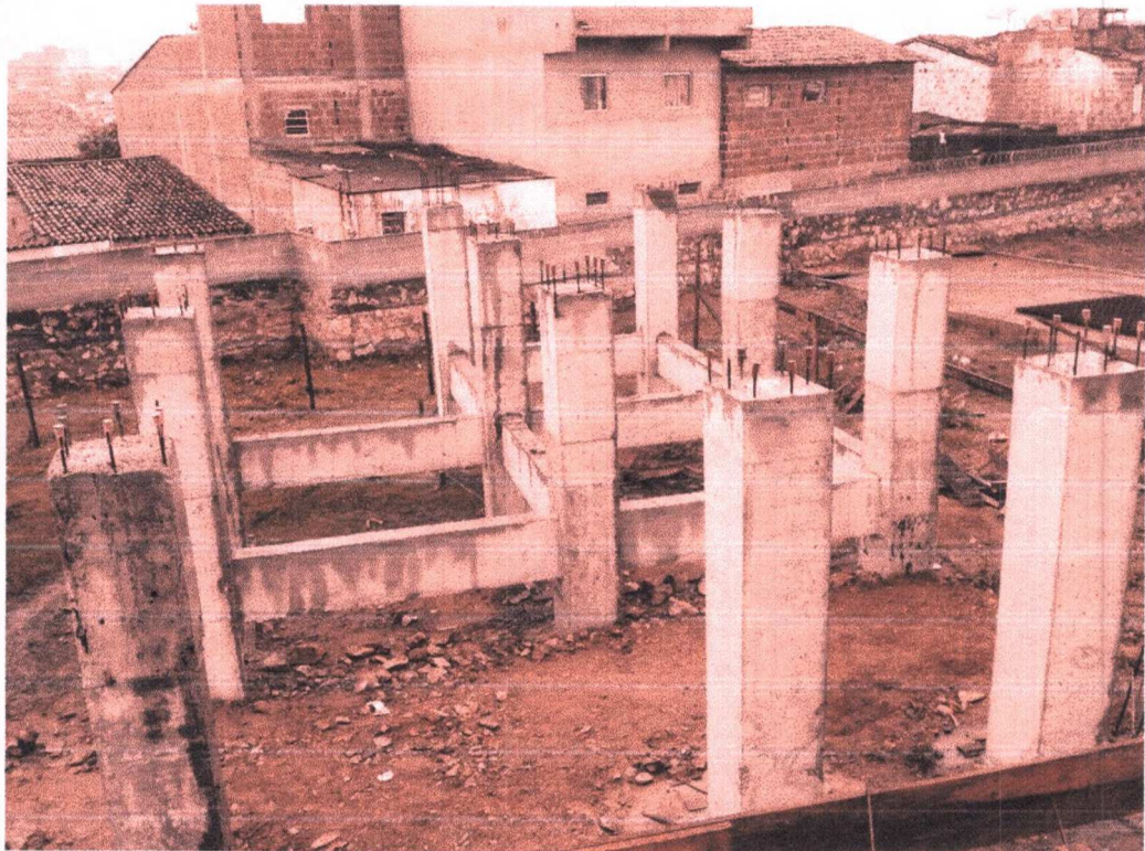
Figura 26 – Fundação do tipo sapata isolada
