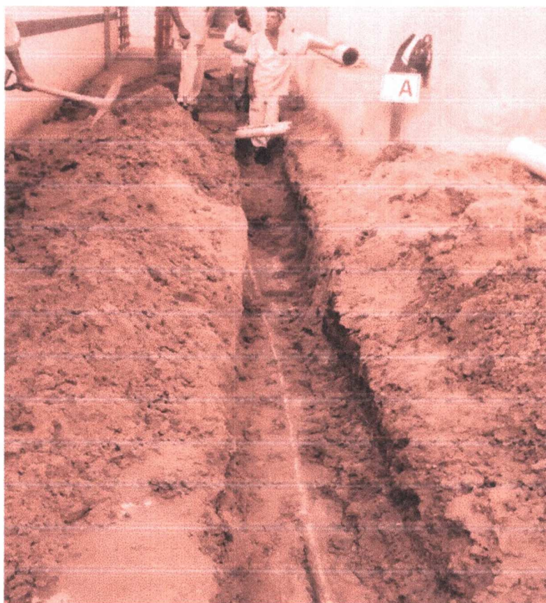
Figura 21 – Escavação de vala para passagem de tubulação de água
