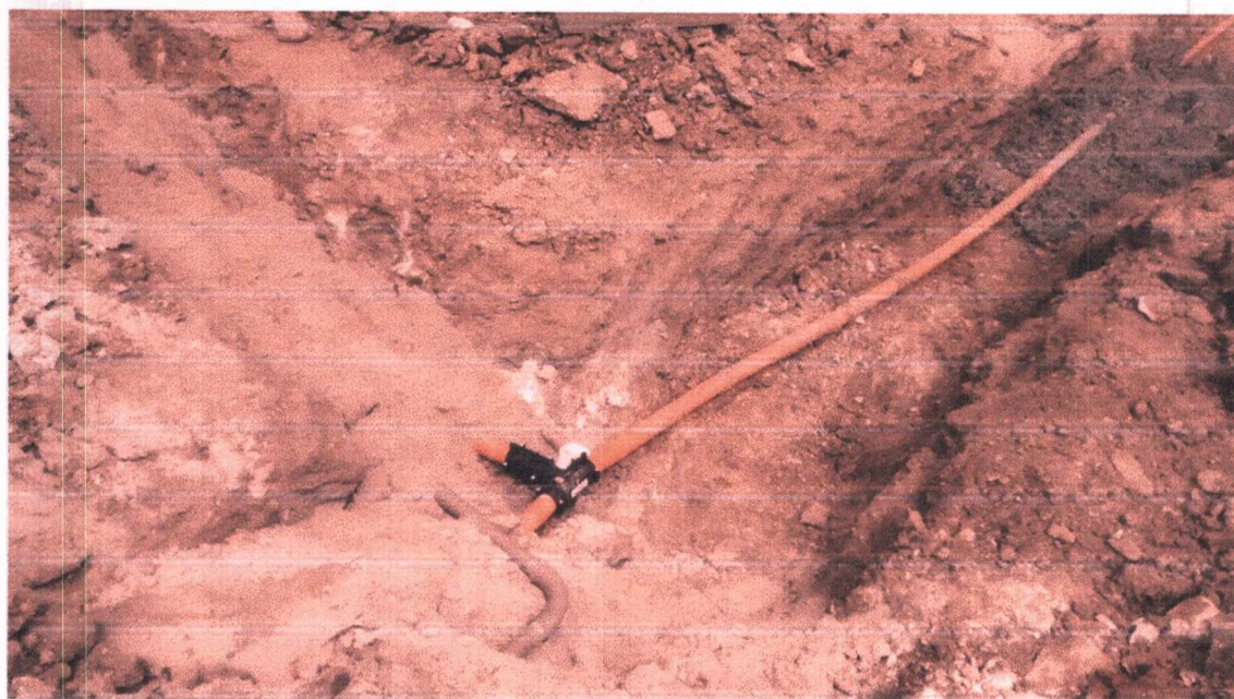
Figura 20 – Escavação de vala para passagem de tubulação de gás
