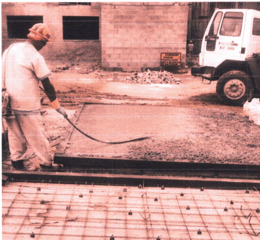
Figura 30 – Passagem do vibrador
