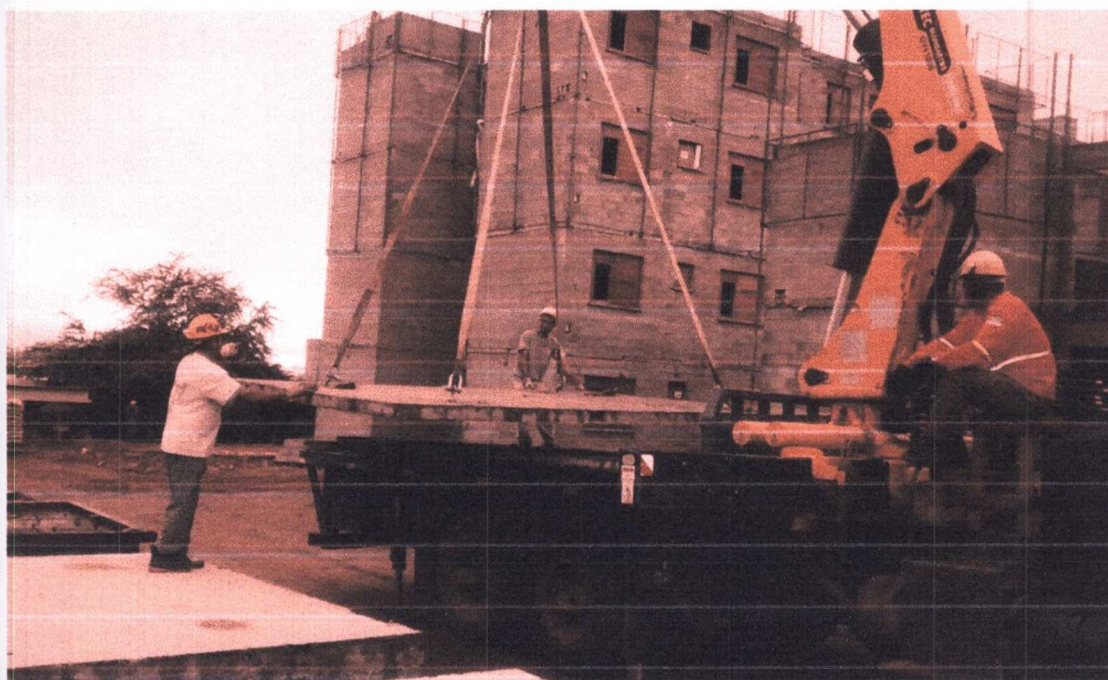
Figura 33 – Retirada de laje para disposição no local de içamento
