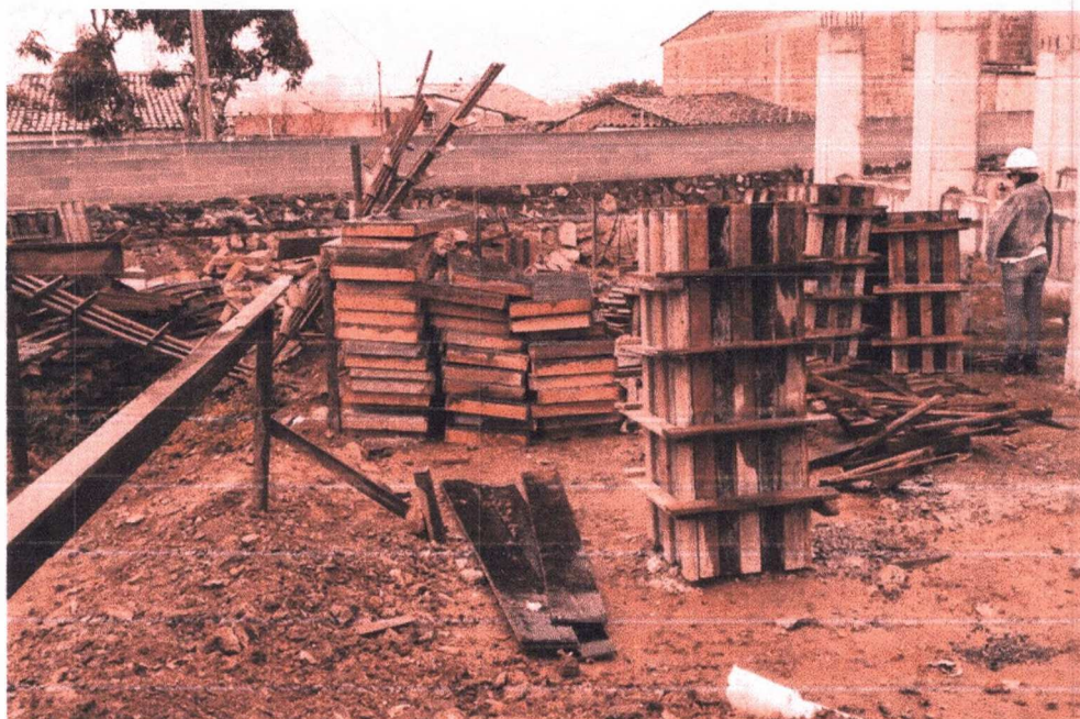
Figura 19 – Fôrmas dos pilares sendo montadas
