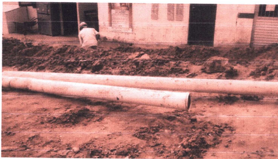
Figura 23 – Escavação de vala para passagem de tubulação de esgoto
