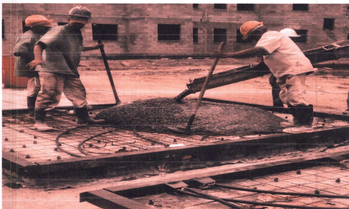
Figura 29 – Concretagem de laje
