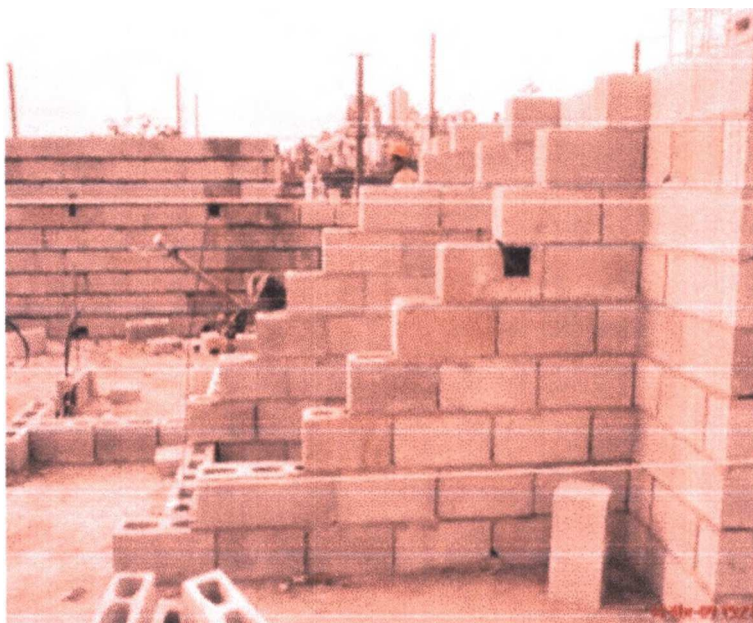
Figura 41 – Elevação da alvenaria em forma de castelo
