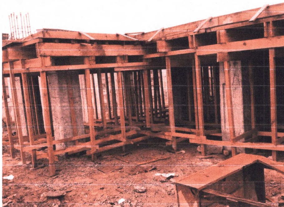
Figura 18 – Fôrmas e escoramentos
