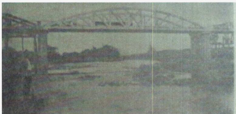
Fotografia 02: Um dos vãos de 21 metros da ponte de Taperoá, depois de retiradas as formas. A ponte mede 64 metros de extensão (1925). Fonte: Jornal A UNIÃO , 31 maio 1925.
