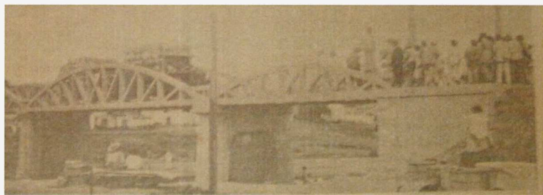
Fotografia 03: Aspecto da ponte de Taperoá no momento em que estacionaram sobre ella 2 caminhões GMC, carregados de algodão, com 17 toneladas (1925). Fonte: Jornal A UNIÃO , 31 maio 1925.
