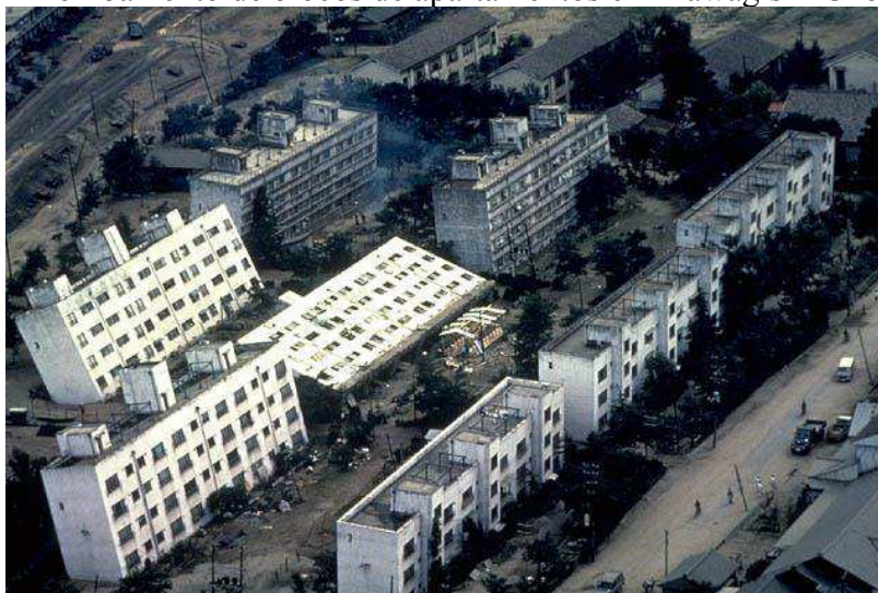
Figura 1 - Tombamento de blocos de apartamentos em Kawagishi-Cho, Niigata.
