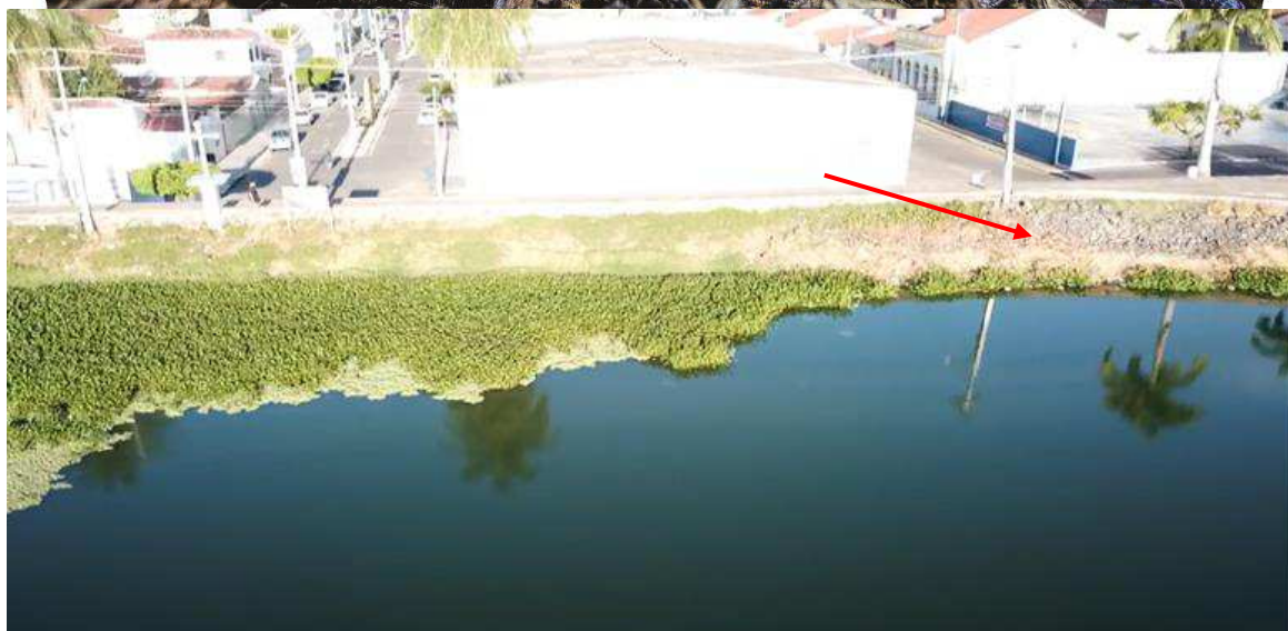
Figura 3. Esgotos lançados no Açude Grande.
