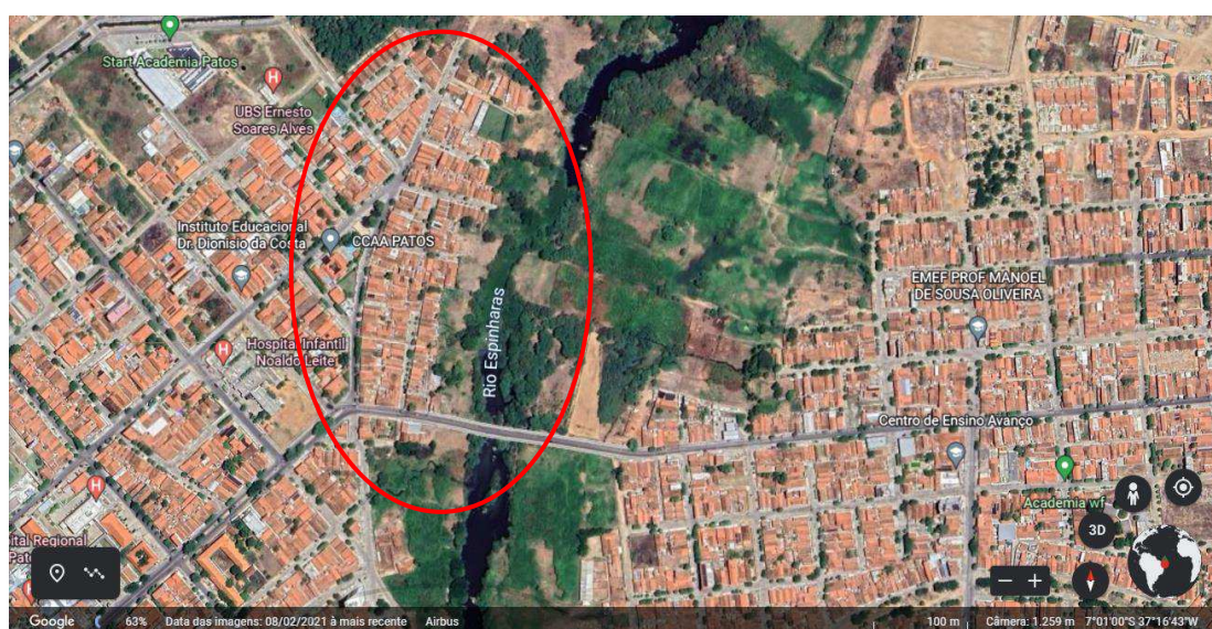
Figura 4. Construções de Residências nas Margens do Rio Espinharas.
