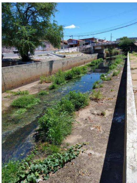
Figura 4. Esgotos lançados no canal da Sangria do Açude Grande.
