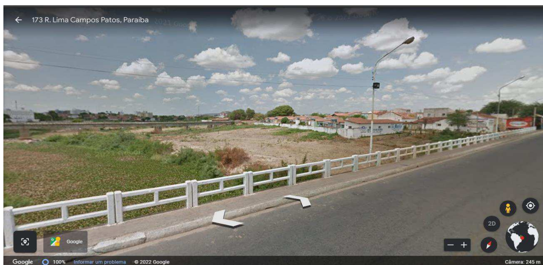
Figura 3. Trecho do Rio Espinharas desmatado com eutrofização e indícios de assoreamento.
