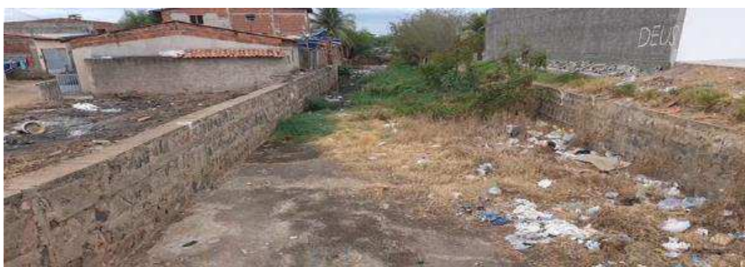
Figura 3. Imagem que retrata o início do canal.
