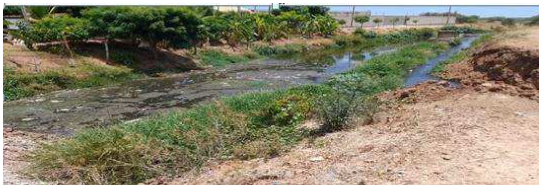
Figura 1. Trecho do canal com desvio para construção de ponte.
