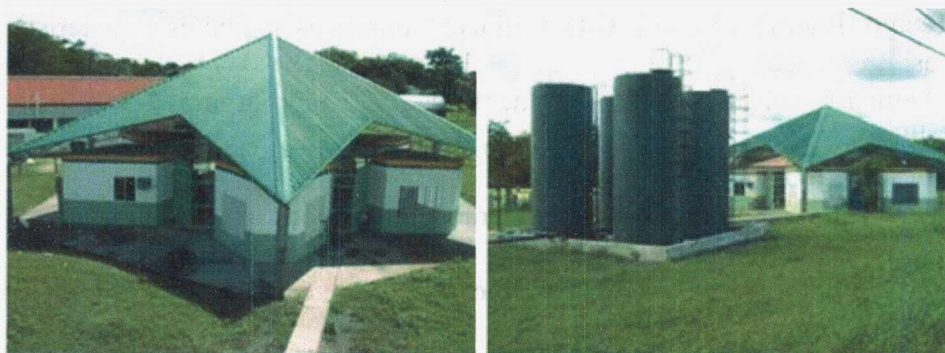
Figura 16: Planta Piloto Industrial com capacidade de produção de 8.000 litros diários de biodiesel, instalada no campo da Universidade Federal de Piauí, Teresina, PI. Fotos de Expedito Parente.
