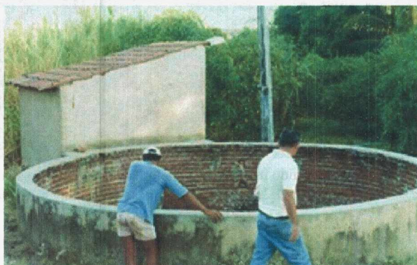
Figura 3: Poço artesiano utilizado pelos produtores para irrigar os campos de algodão através de motor bomba elétrico. Bom Sucesso - PB, ano 2000. Foto de Vicente de Paula Queiroga.
