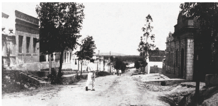
49 Com a terraplanagem, a construção de calçadas e a pavimentação da rua Irineu Jofilly (foto abaixo - início dos 1930), as águas das chuvas passaram a escoar, em direção ao Açude Velho, pelas calhas executadas nos cantos da via, sem a abertura de sulcos que outrora acumulavam lixo (foto acima - 1930). Fonte: Arquivo pessoal Severino Cabral Filho.
