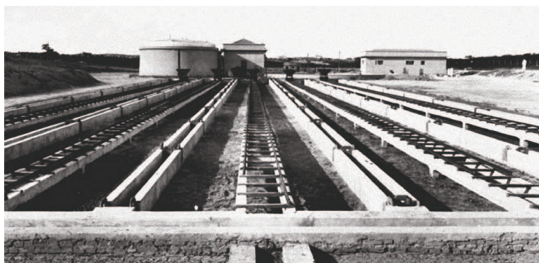
48 Estação Depuradora de Campina Grande. Fontes: Sampaio, 1947, p.320. Arquivo Humberto Nóbrega - Unipê (Acervo pessoal Francisco Sales Trajano Filho).
