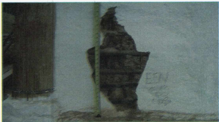
Imagens de sondagens da edificação rural.
