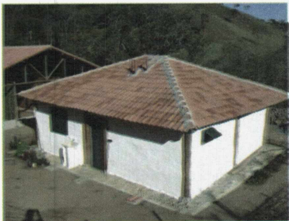
Vista superior externa do imóvel residencial.
