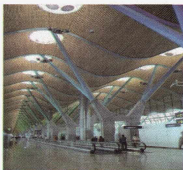
Detalhes da cobertura do aeroporto internacional de Barajas, em Madrid, vista do forro em lâminas de bambu e das estruturas metálicas de sustentação dos vãos. (richard bryant / arcaid.co.uk).
