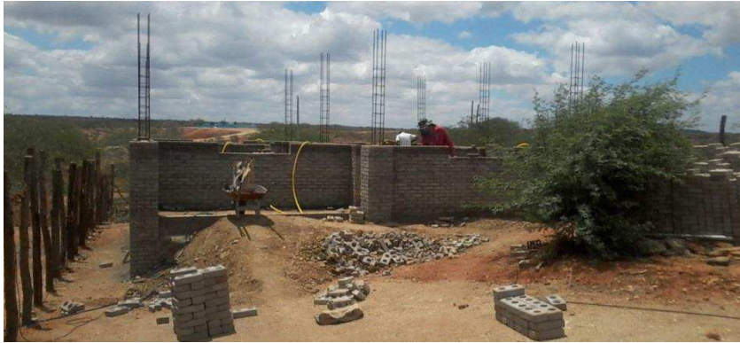
Figura 2. Vista frontal da construção da eco residência.
