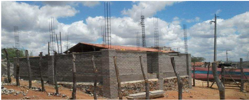
Figura 3. Vista lateral da construção da eco residência.
