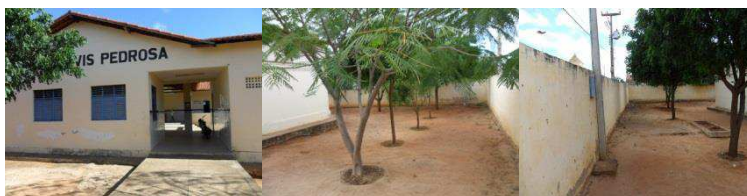
Figura 2. Fachadas da escola, lateral direita e lateral esquerda da entrada.
