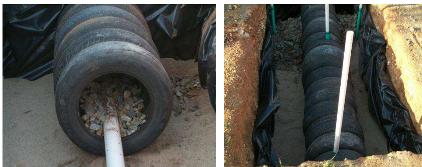
Figura 5. Fase final do preenchimento dos tanques evaporímetro.
