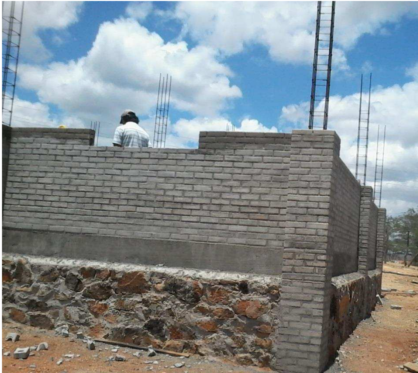
Figura 5. Vista da fundação da construção da eco residência.
