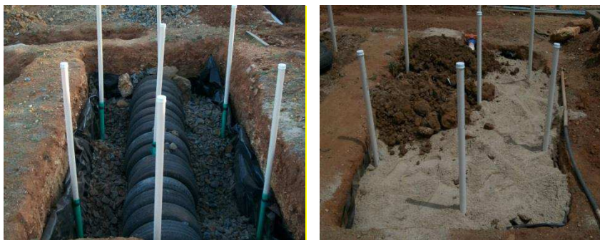
Figura 4. Início do preenchimento do tanque.
