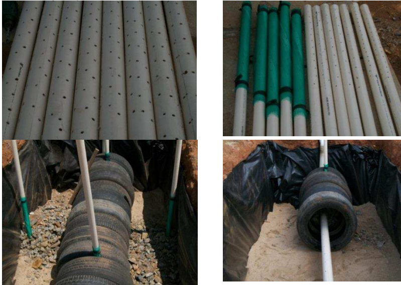
Figura 2. Tubos de PVC perfurados e a montagem dos tanques instalando os tubos e os pneus.
